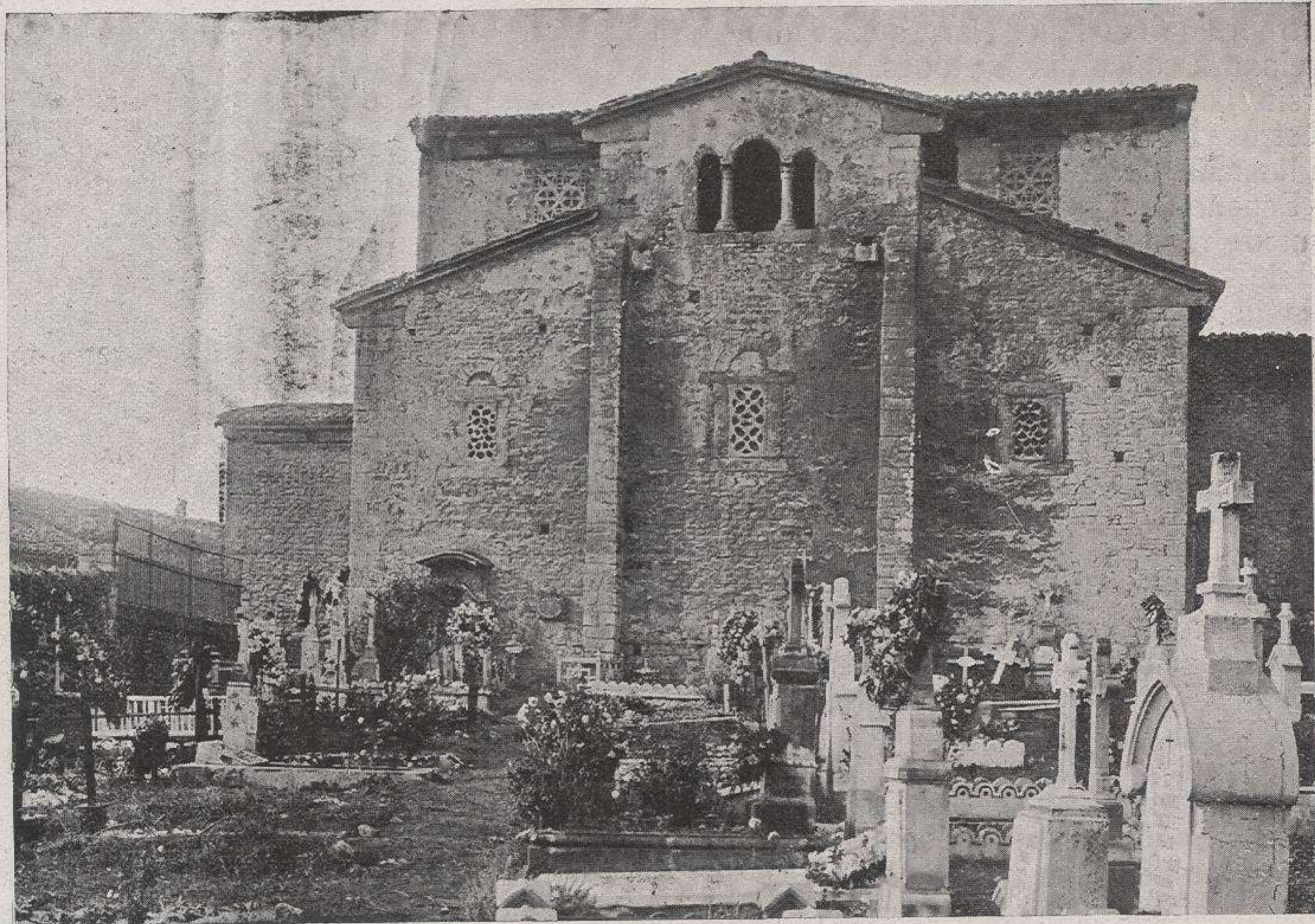
Notabilísimo ábside de la iglesia parroquial de Santullano de Oviedo.
