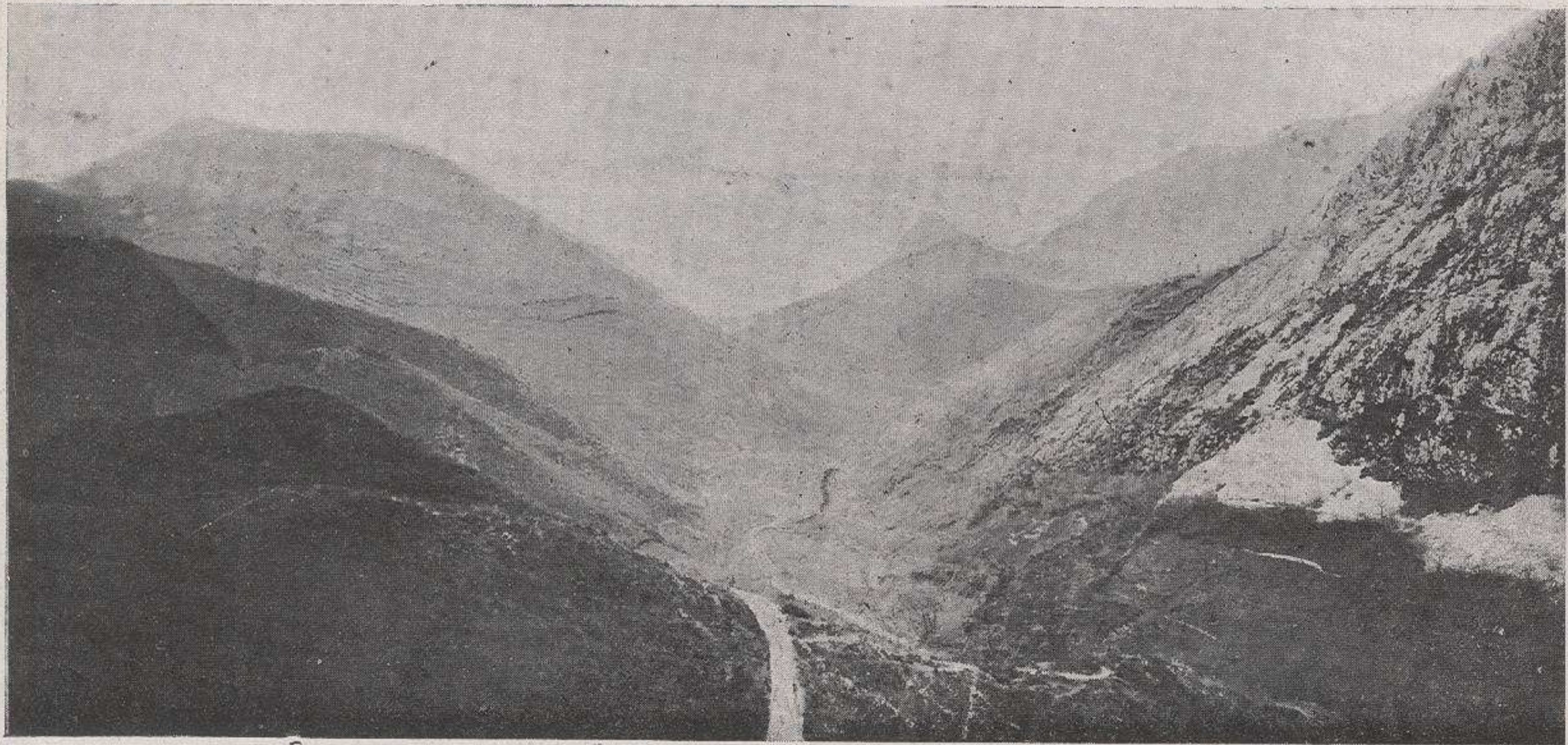
Alto de la carretera de Zardón.
