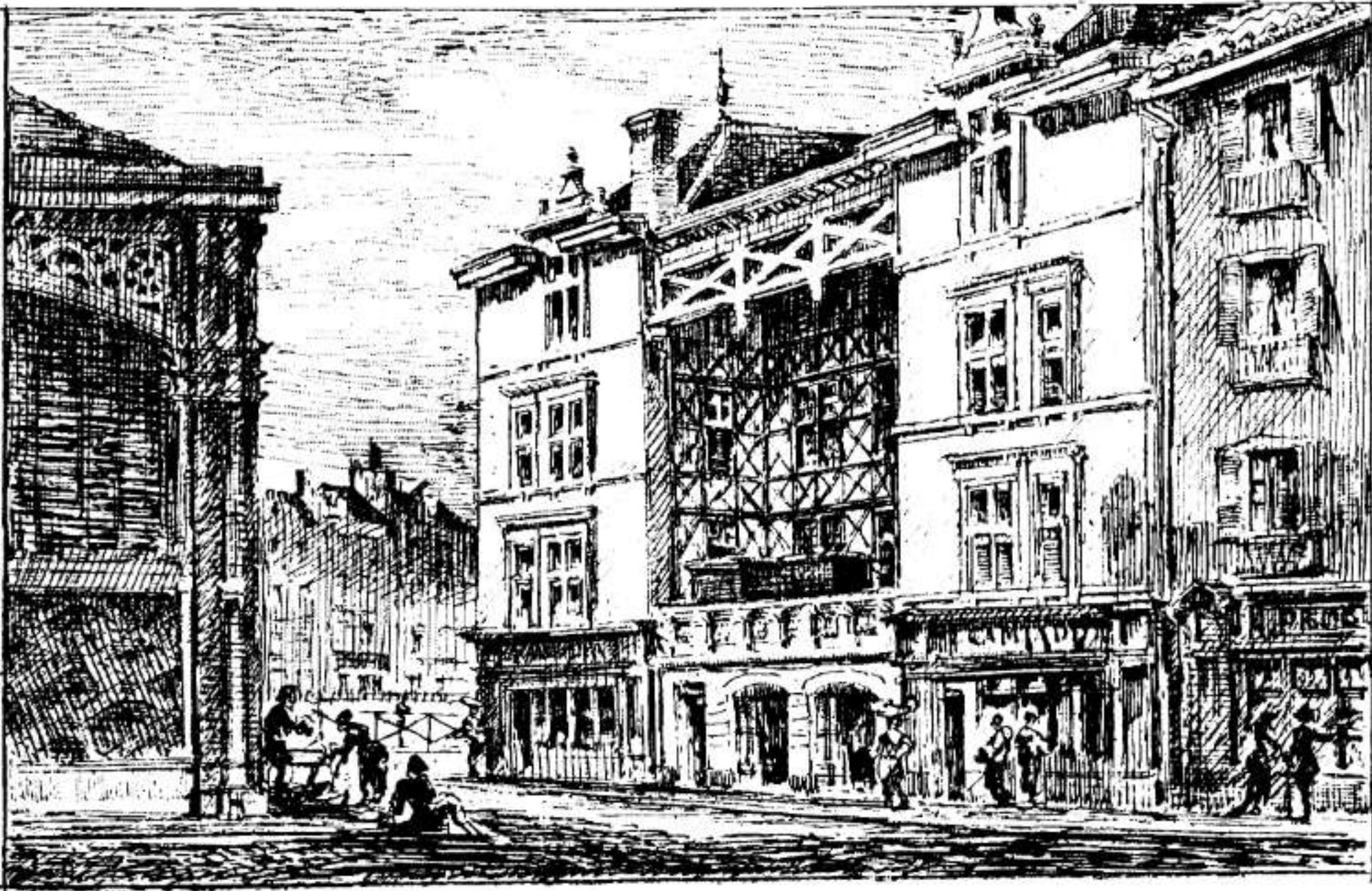
11. Maison de la rue Poissonnerie, à Bayonne
