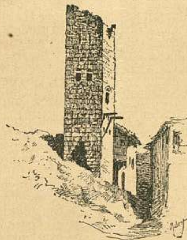
Una de las torres antiguas de Camarasa.
