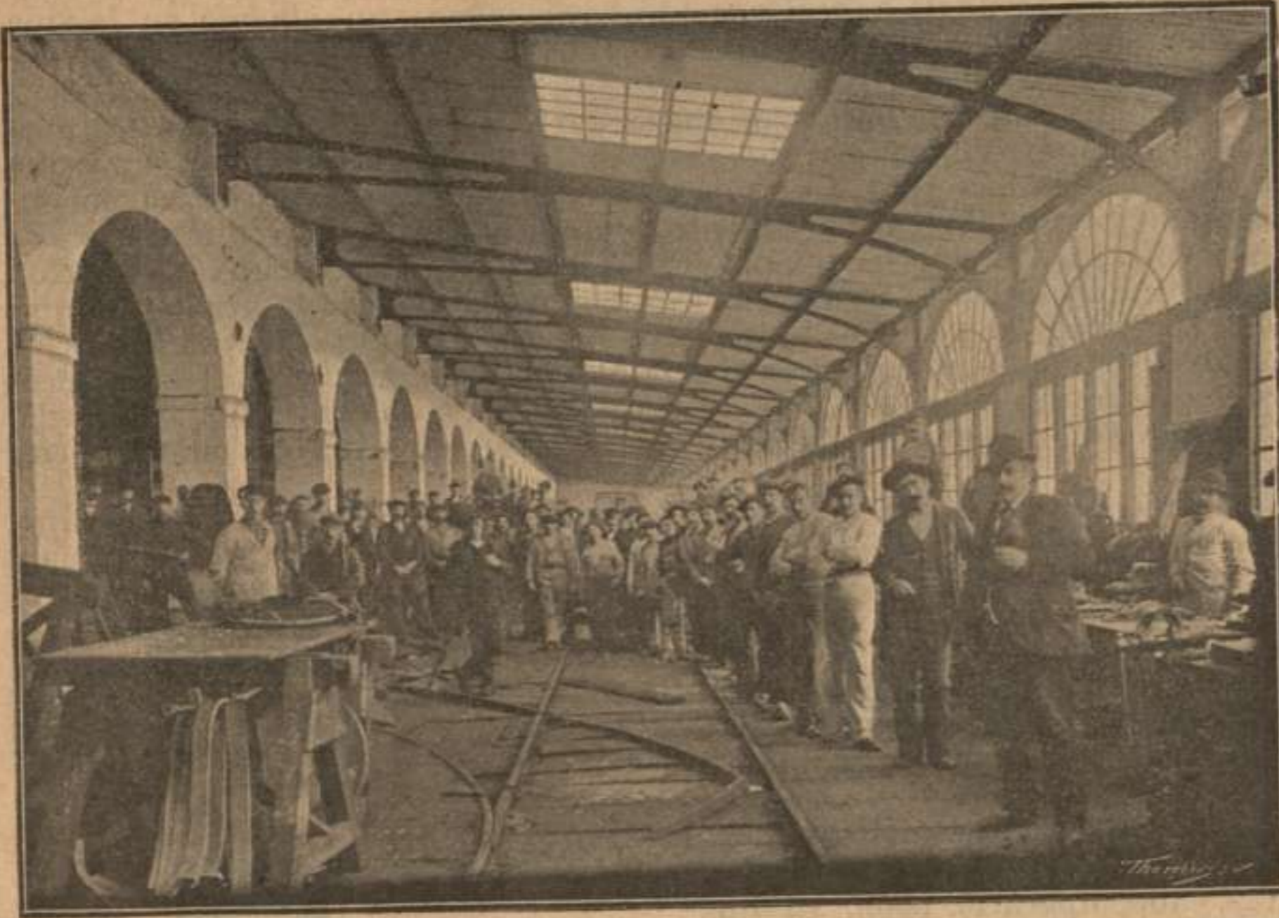
ASTILLERO.—NAVE DEL TALLER DE MAQUINAS
