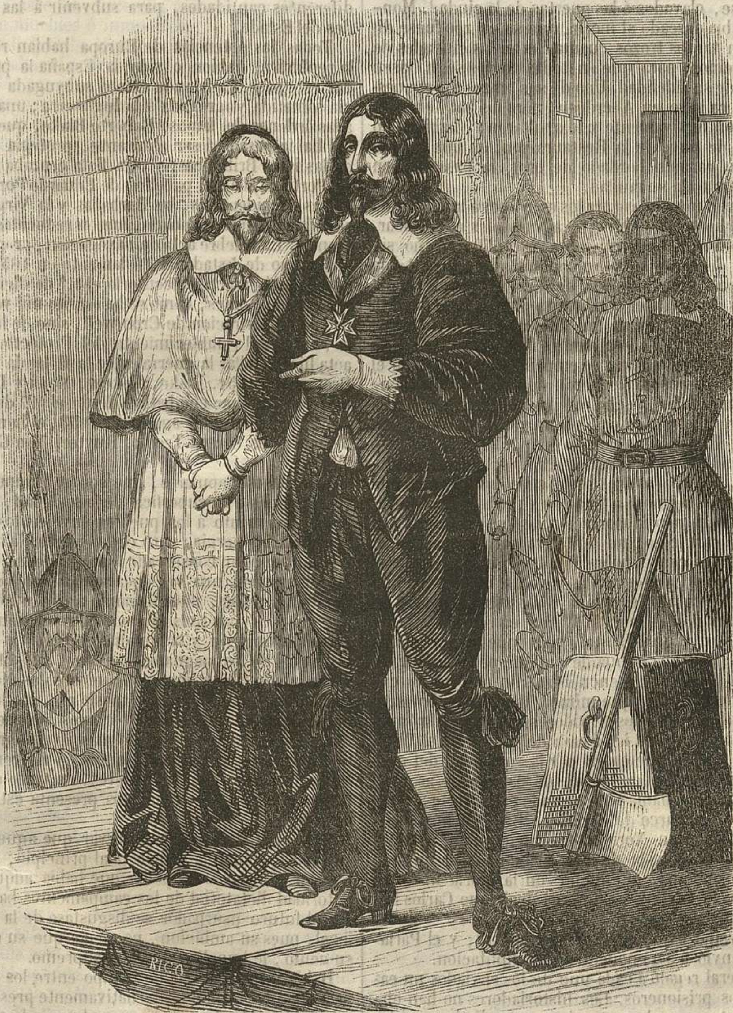
EJECUCION DE CARLOS I.
