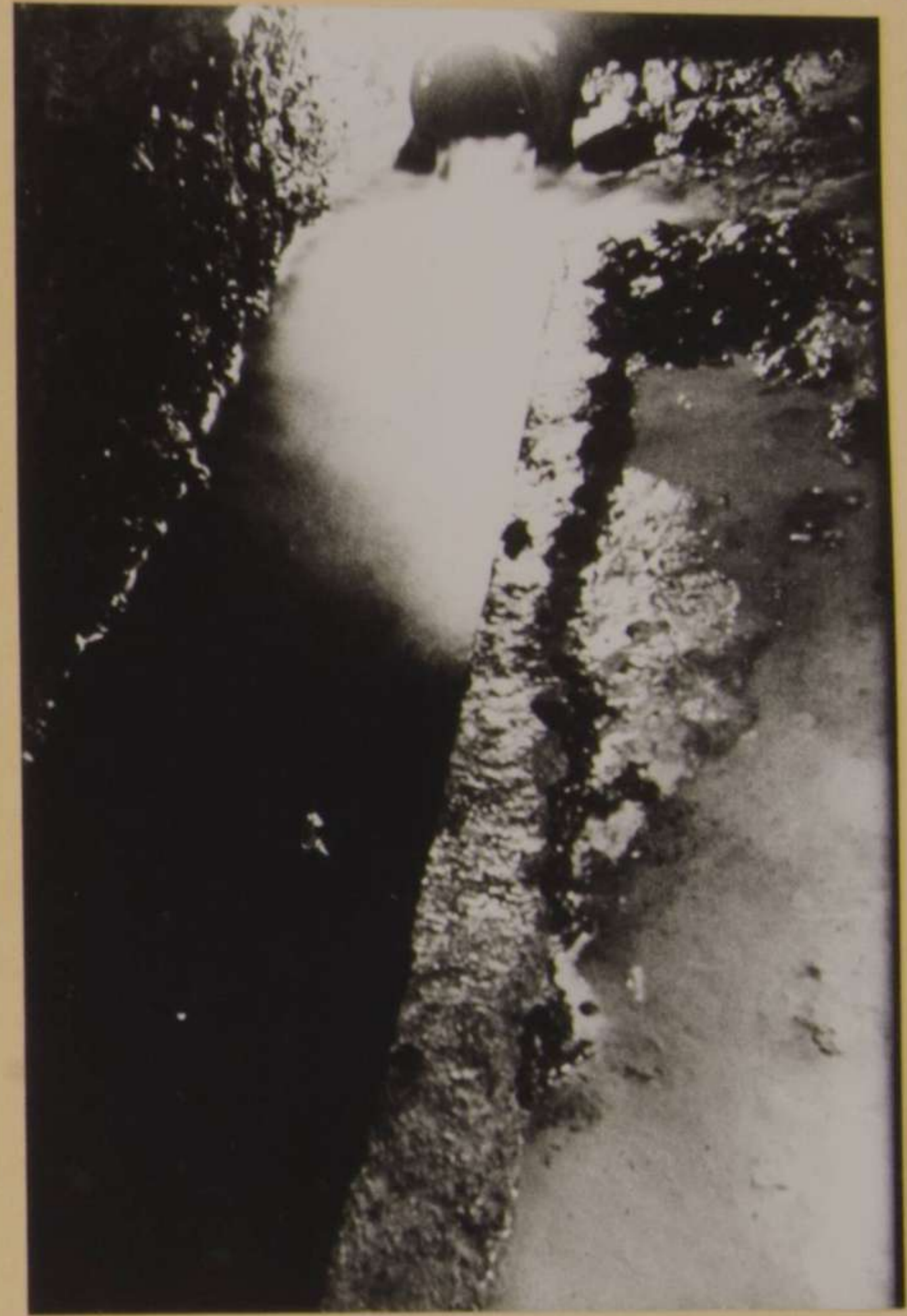
CAMARETAS.—SALIDA DEL AGUA DEL NUEVO RAMAL DE GALERIA.
