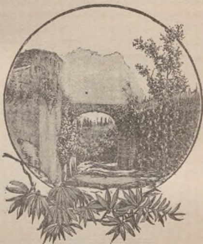
TORRE DEL AGUA, PRÓXIMA Á LA DE LOS SIETE SUELOS.
