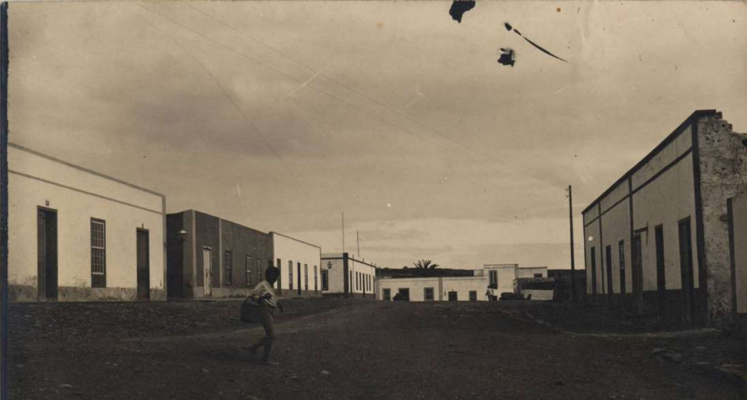
Calle Fernandez Castañeyra Puerto de Cabras - Fuerteventura
