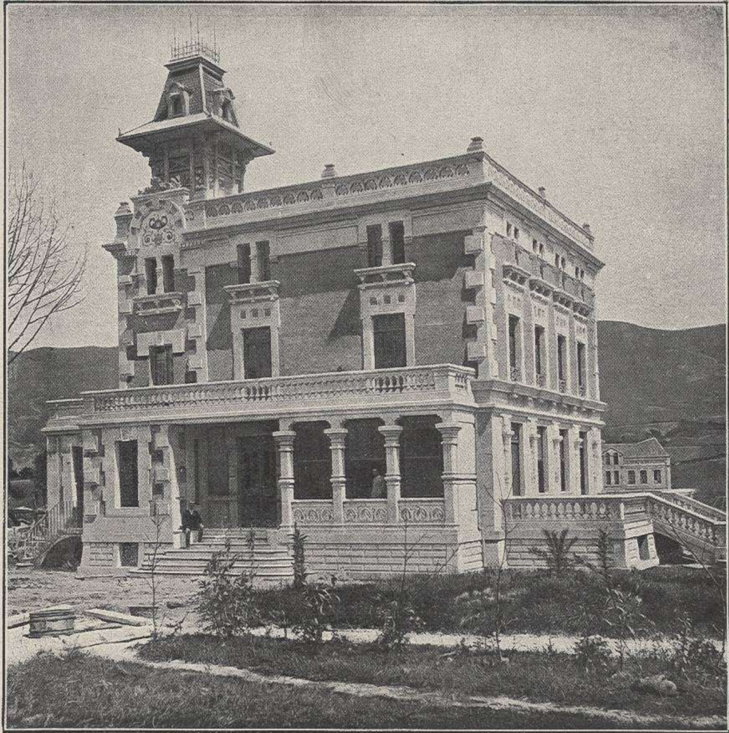
—Hotel del banquero D. Arturo López (Oviedo), todo de hormigón armado y piedra artificial.
