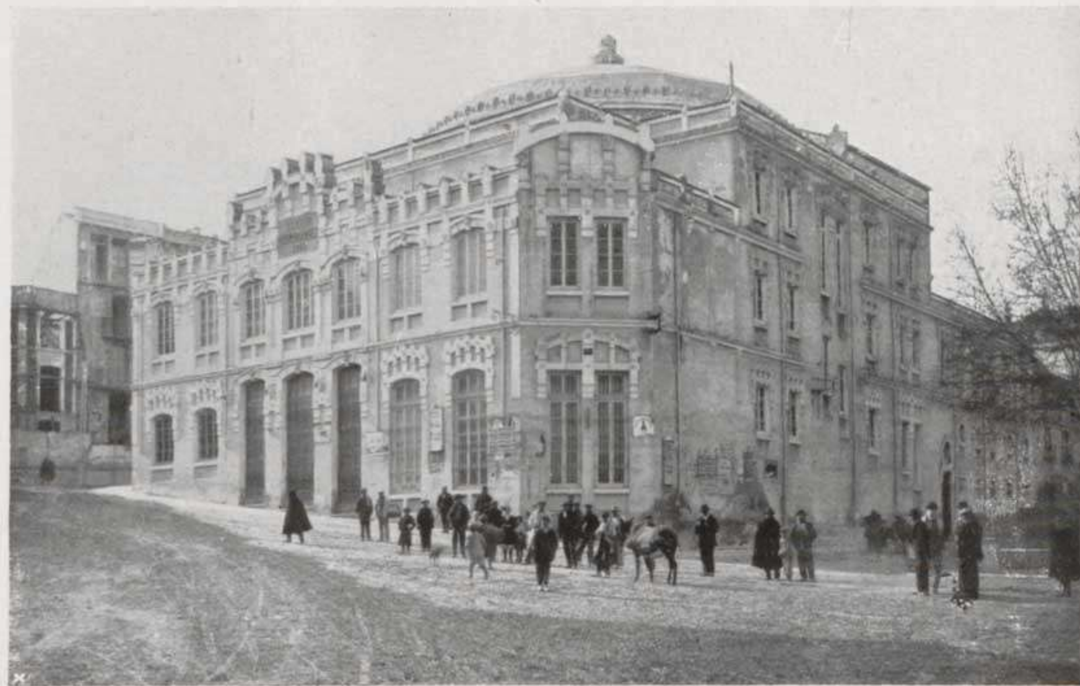
Es el principal coliseo con que cuenta esta localidad, habiéndose concluido en 1908 las obras efectuadas.
