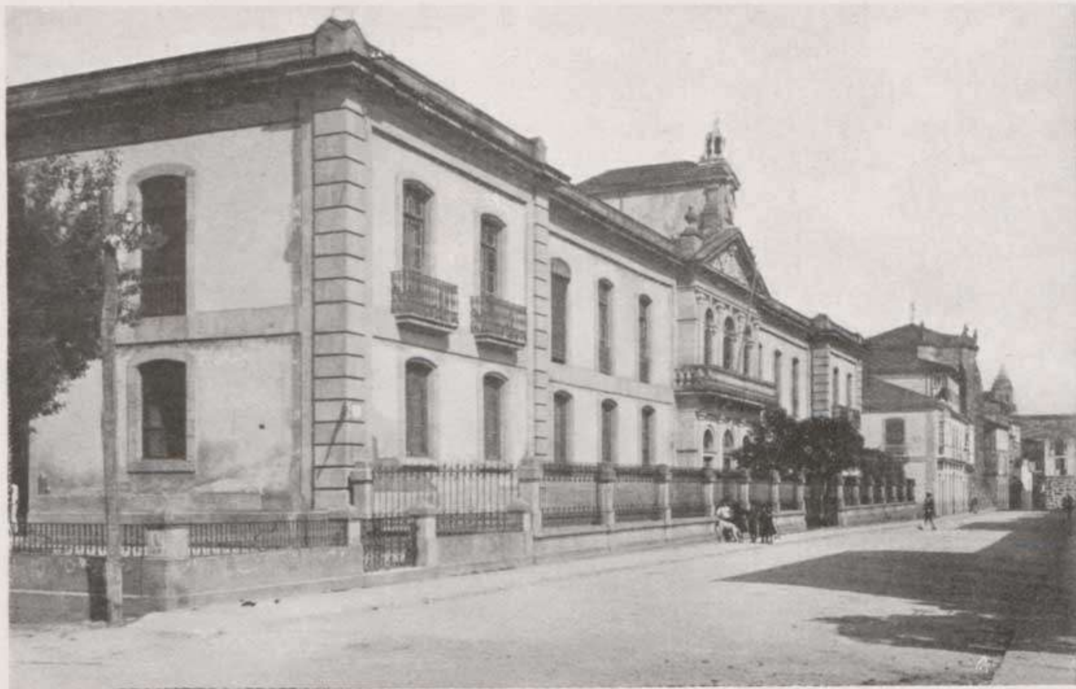
Construcción de tres cuerpos en su fachada, con la capacidad suficiente para los fines á que está destinado.
