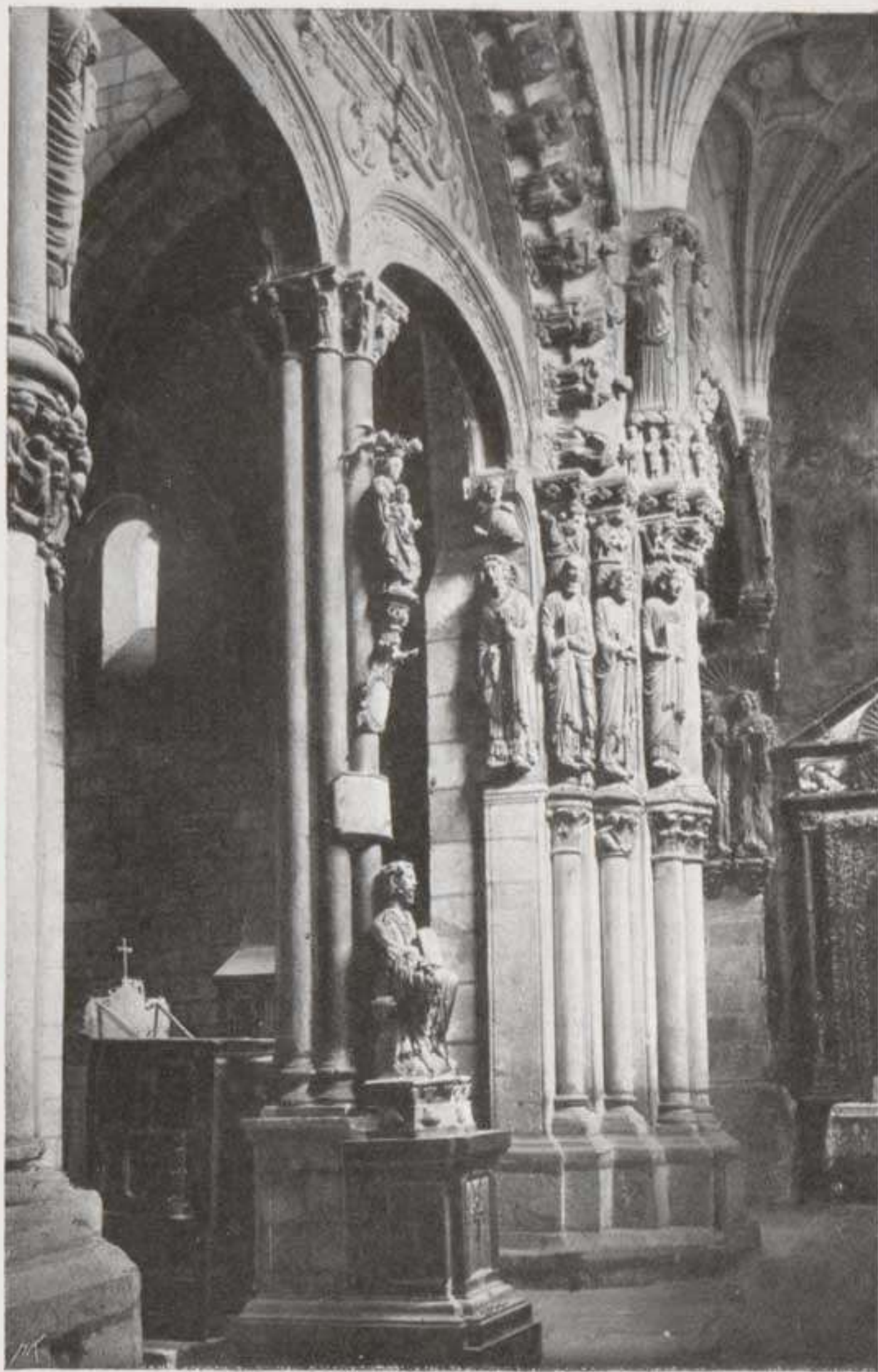
Construido á semejanza del de la Catedral de Santiago, consta de tres arcos, correspondiendo á las naves del templo en cuyo interior se encuentra.
