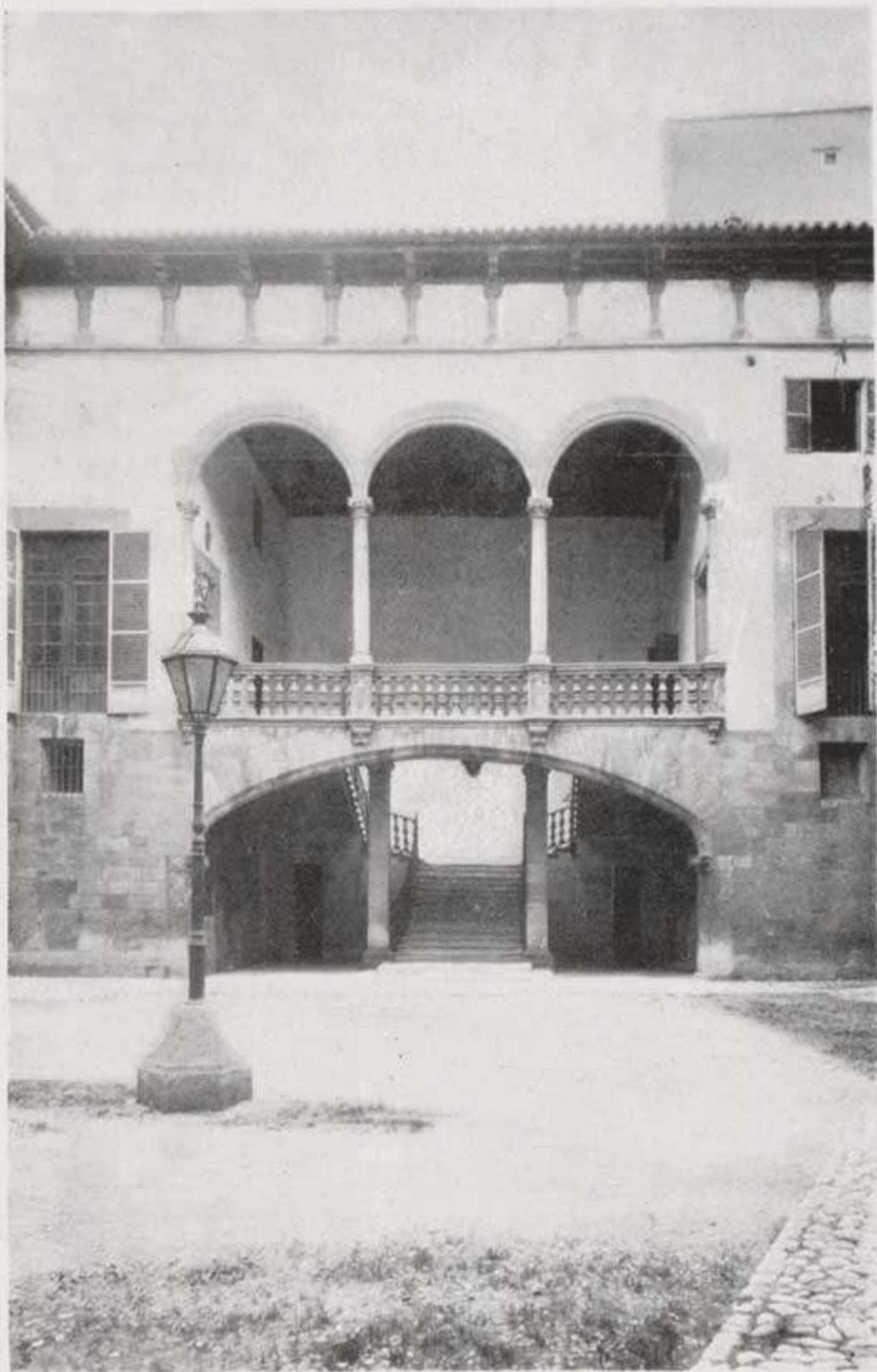
Descuella entre las varias casas señoriales que se encuentran en la Ciudad, ostentando hermosa galería y balaustrada estilo Renacimiento.
