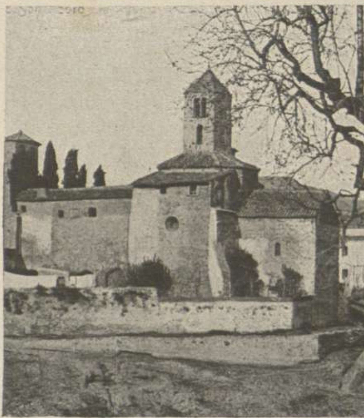
Fig. 18. — Santuari de Santa Maria de Terrassa abans de la restauració
