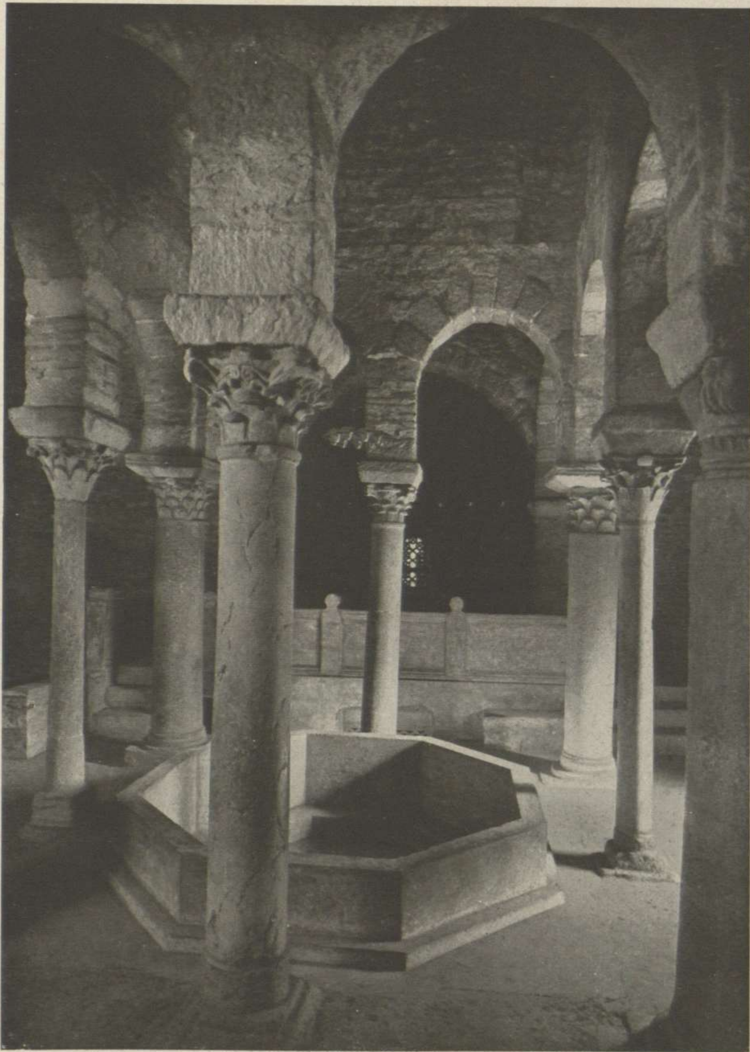
Fig. 45.—Seu d'Egara : Baptisteri de Sant Miquel (la barana de la pila baptismal i el cancellum del presbiteri són de la restauració moderna) (Ribera i Llopis)
