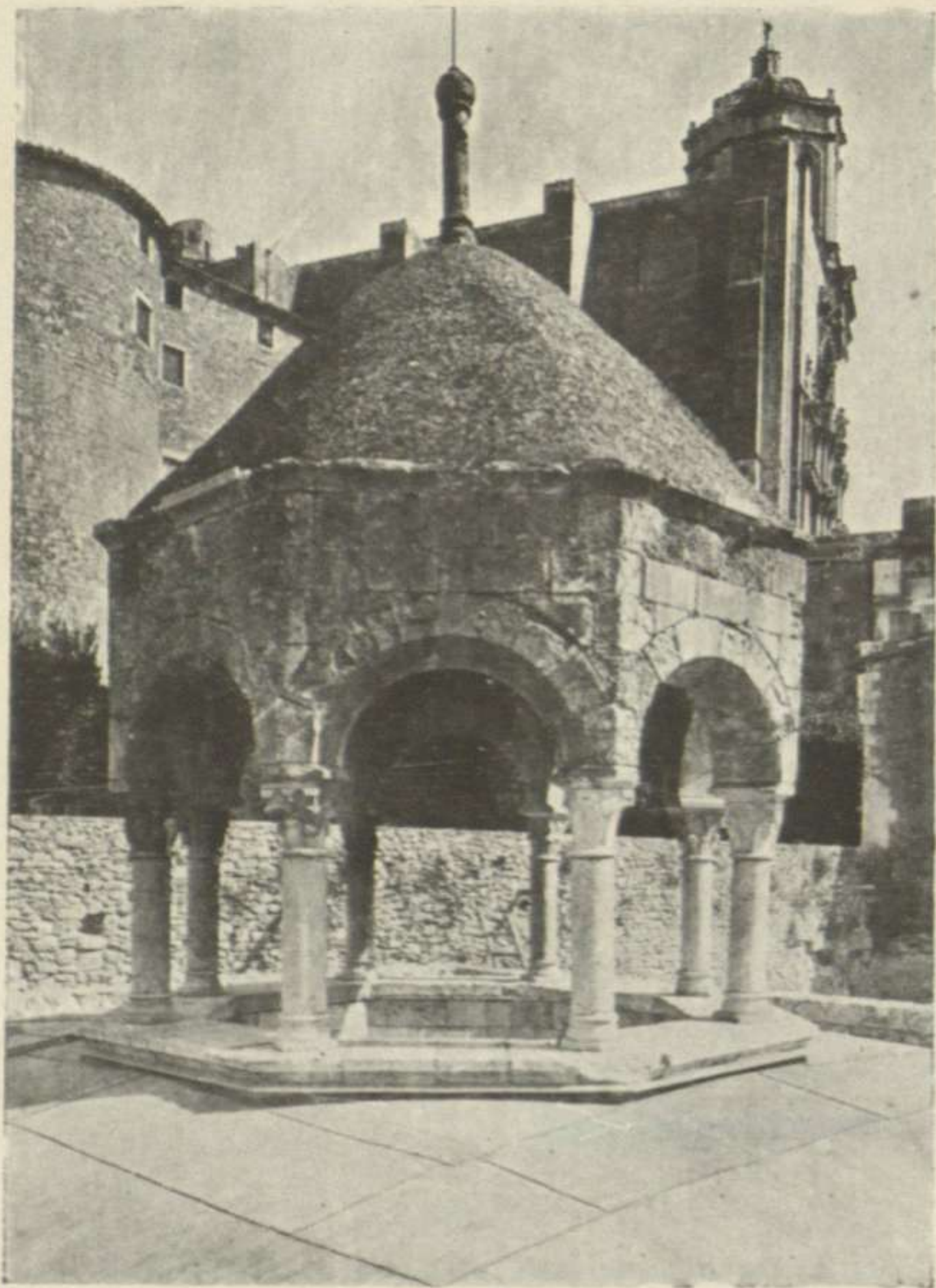
Fig. 6. — Cupulí exterior de la gran sala freda. (Sobies.)
