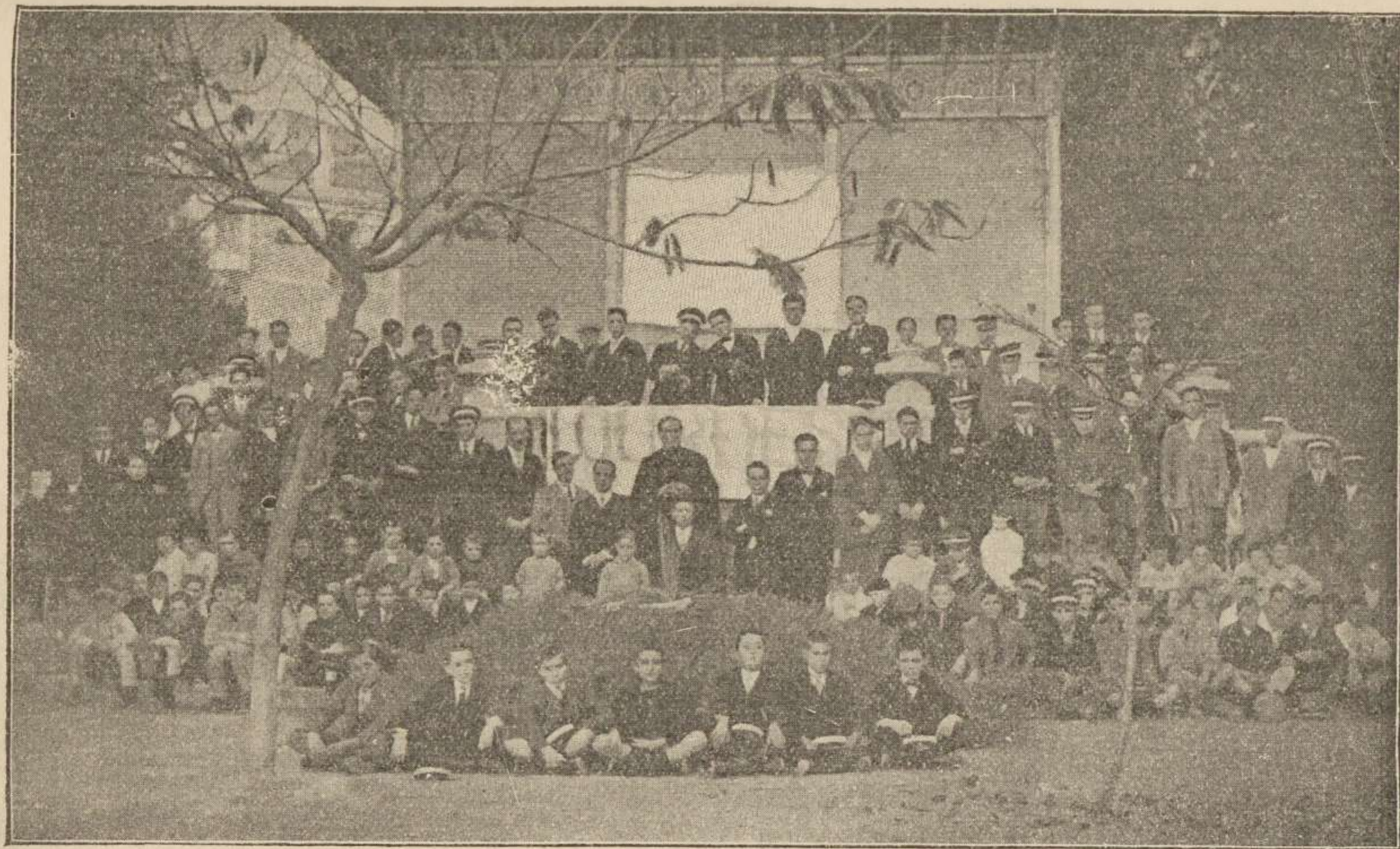
Estado actual del internado de la obra católico-social y pedagógica de Ntra. Sra. de Lourdes de Murcia.
