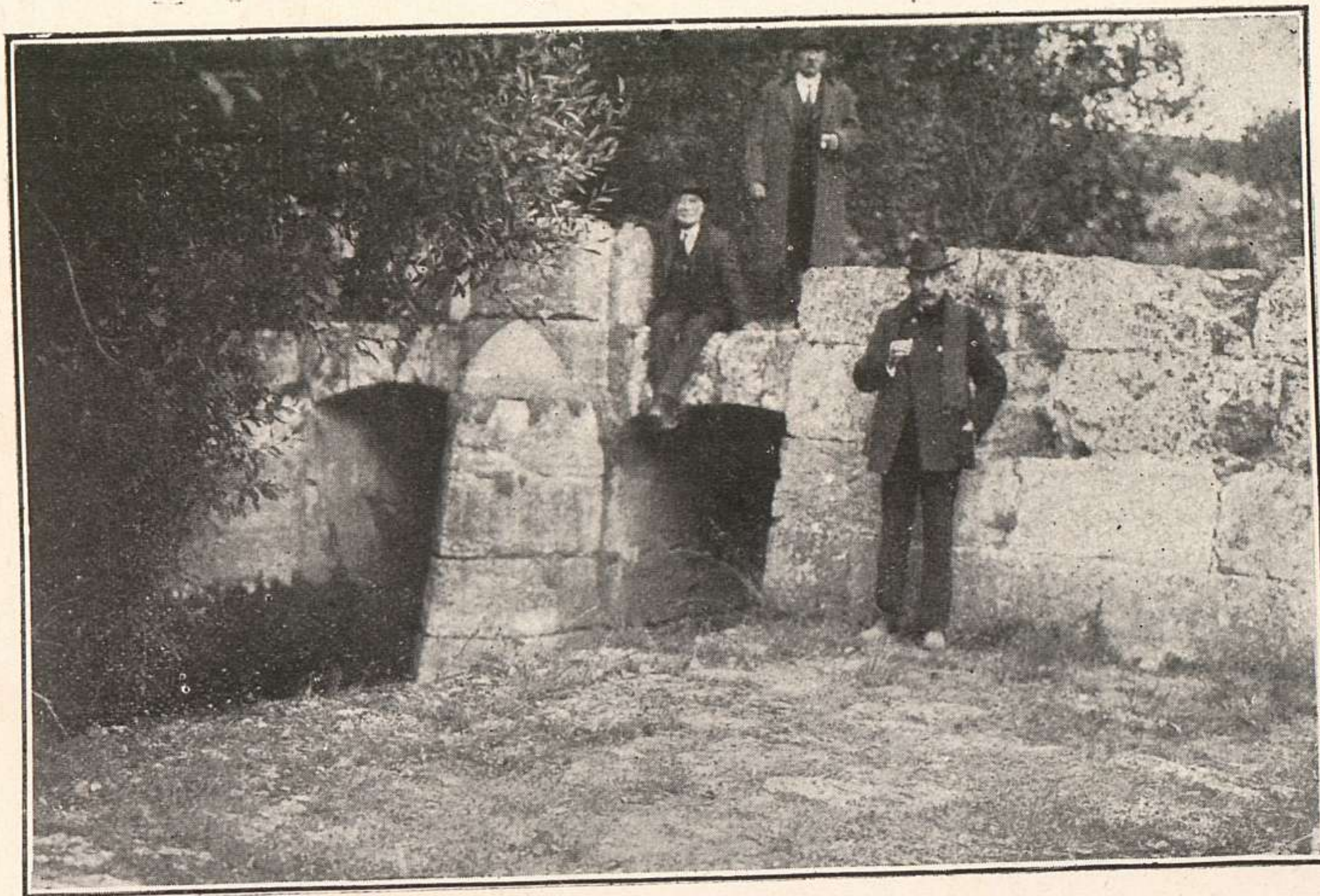
HUÉSCAR / DOBLE TOMA EN EL RÍO GUARDAL PARA EL CANAL DE LORCA
