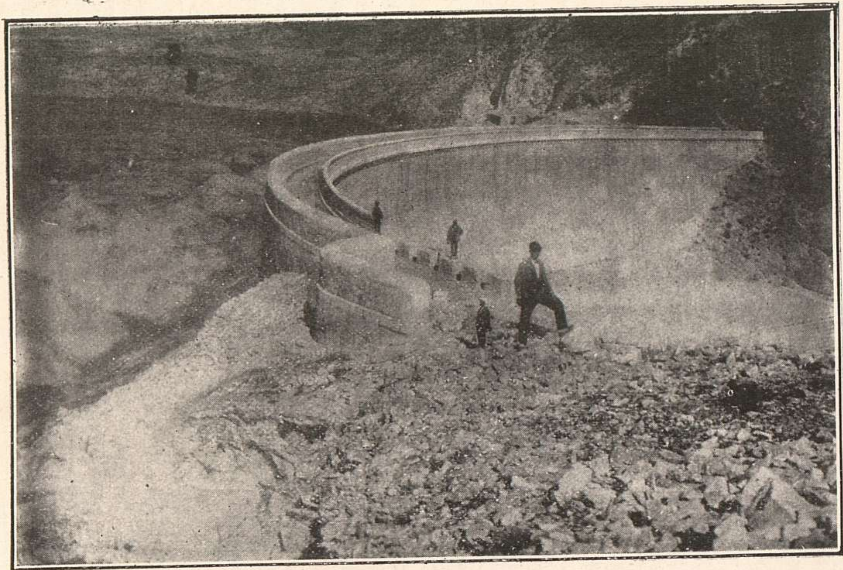
LORCA / PANTANO DE VALDEINFIERNO CON EL MURO DE SU PRESA RECRECIDO
