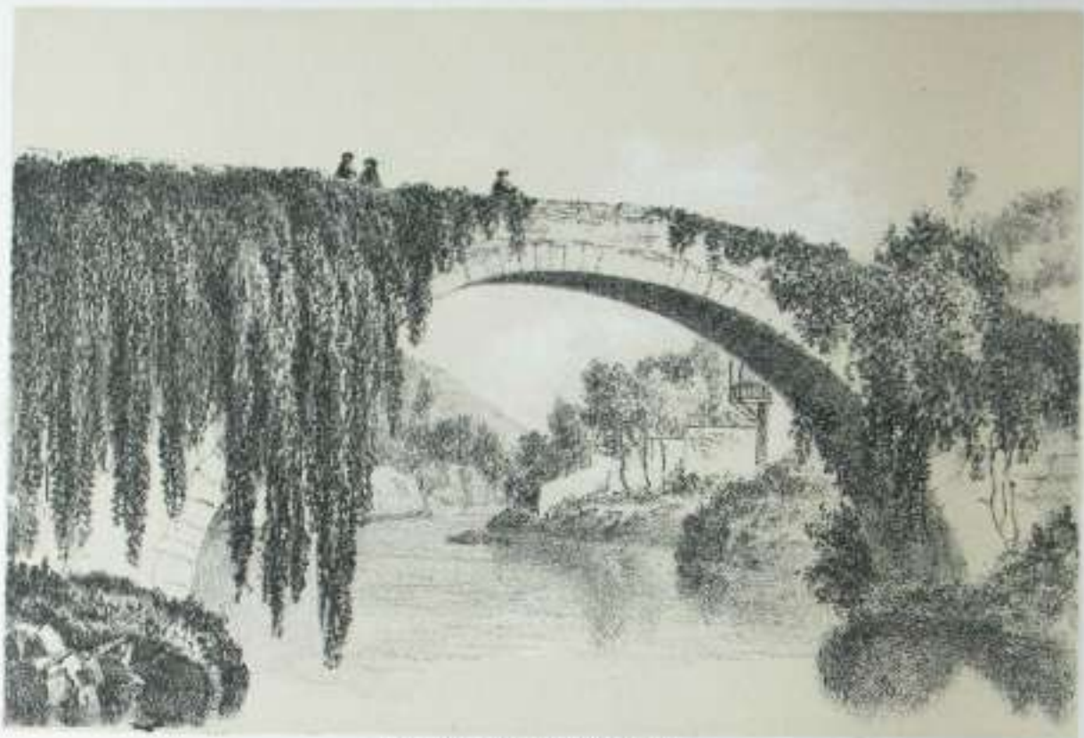
PONT DE LESTELLE
