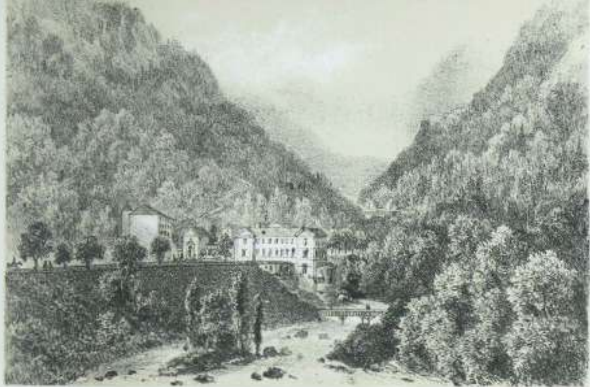
L'ÉTABLISSEMENT DES EAUX CHAUDES.
