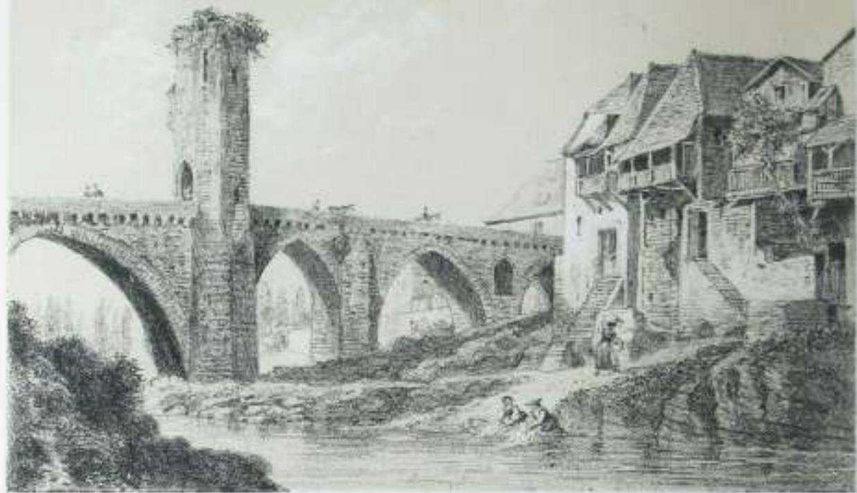
VUE DU PONT D'ORTHEZ
