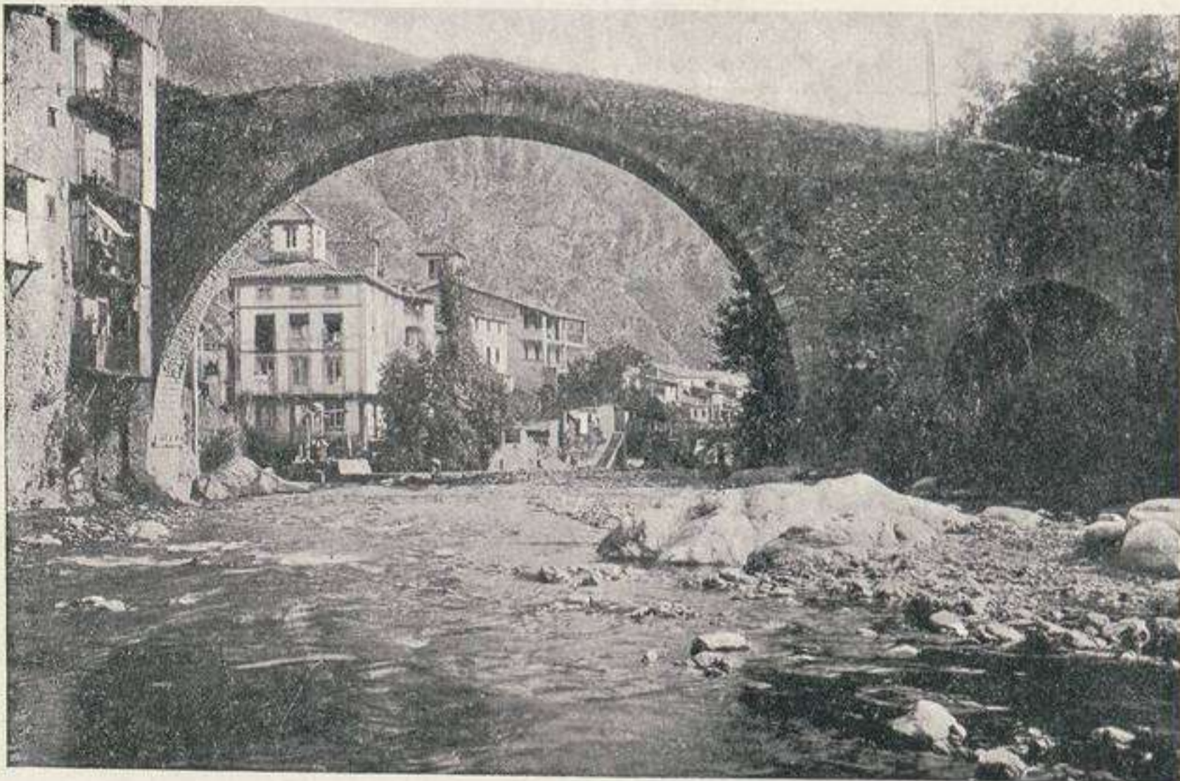
Camprodón. — El llamado puente nuevo (construcción del siglo xvi)
