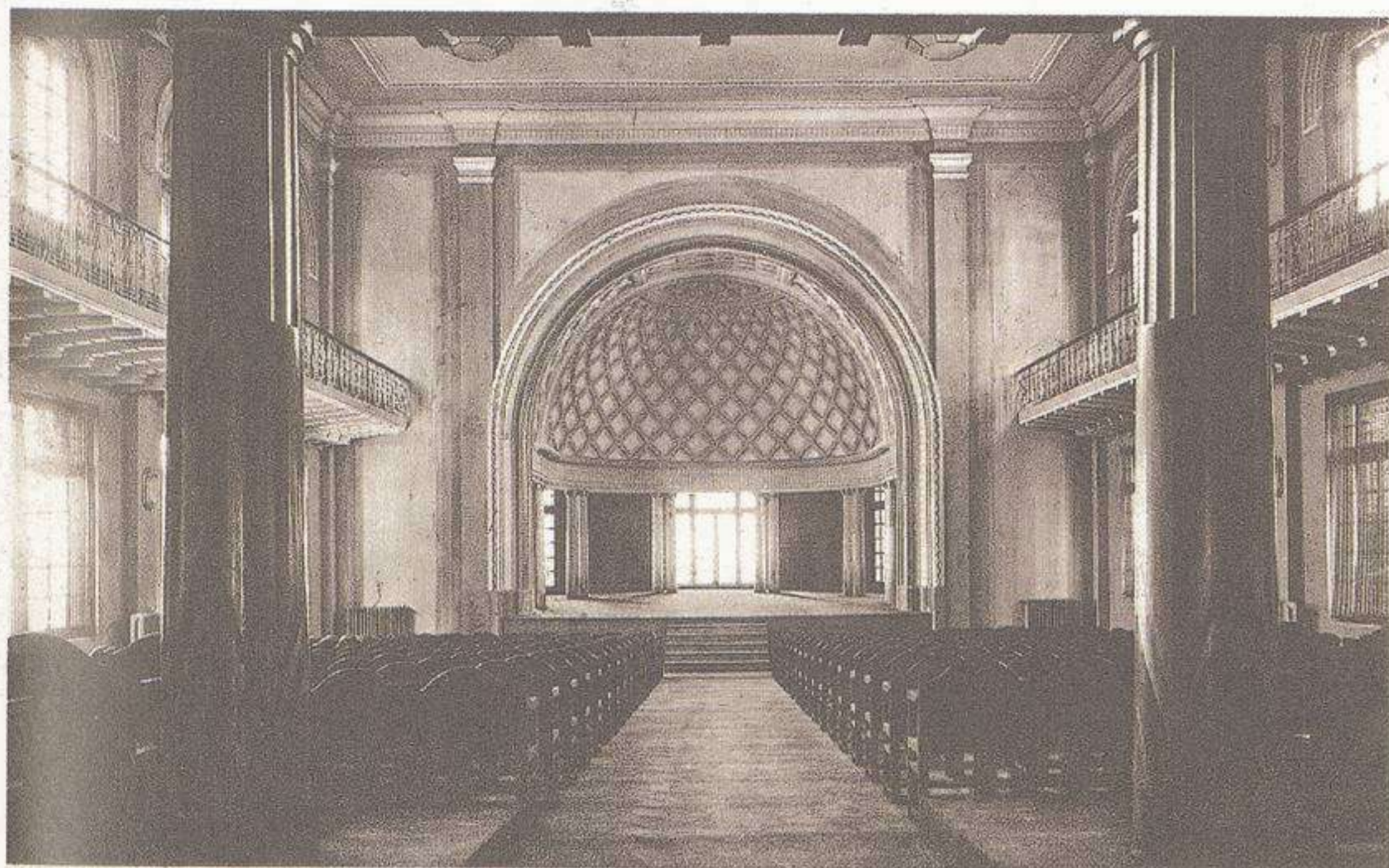
ZARAGOZA - GRUPO ESCOLAR COSTA. Salón Teatro
