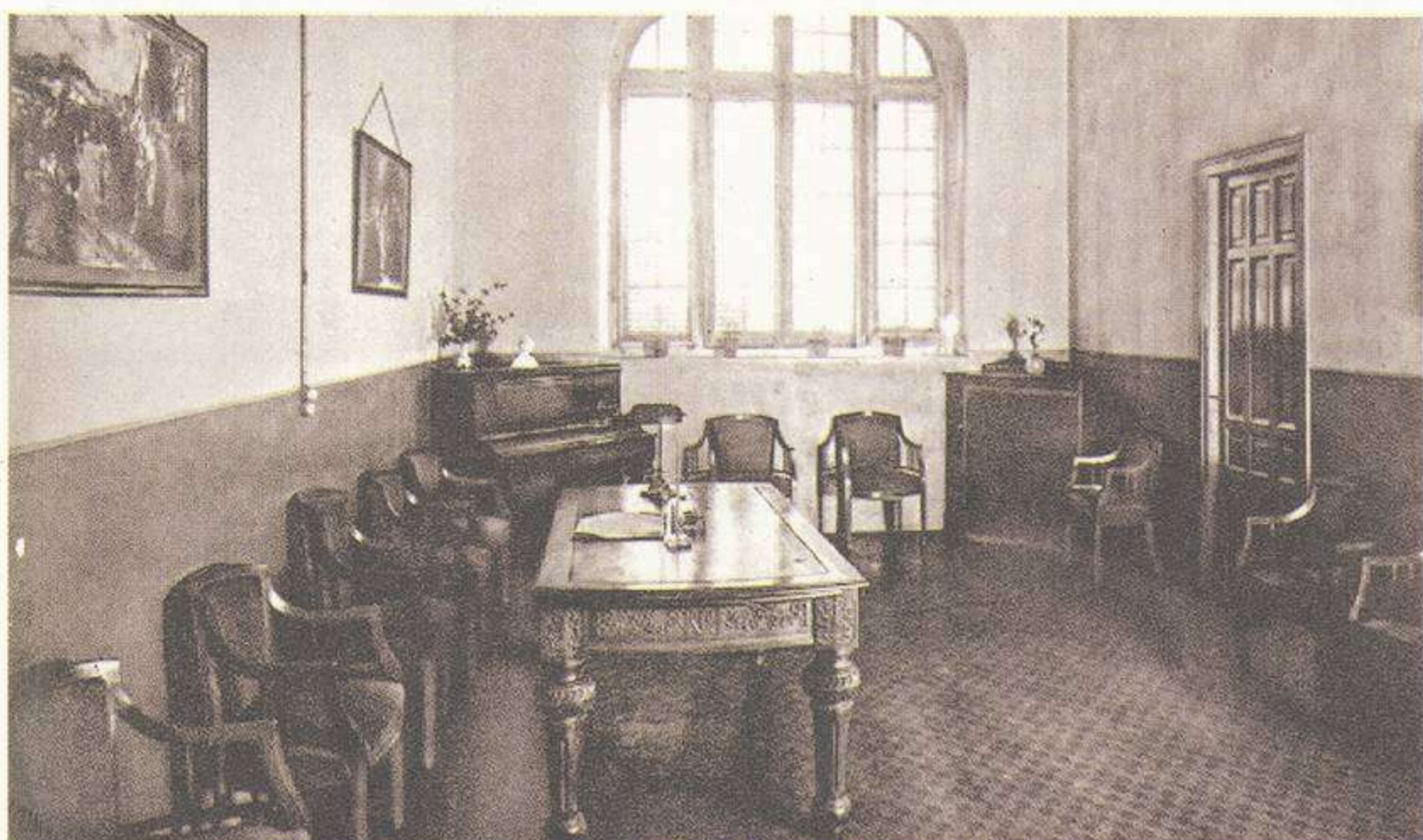
ZARAGOZA - GRUPO ESCOLAR COSTA. Sala de visitas
