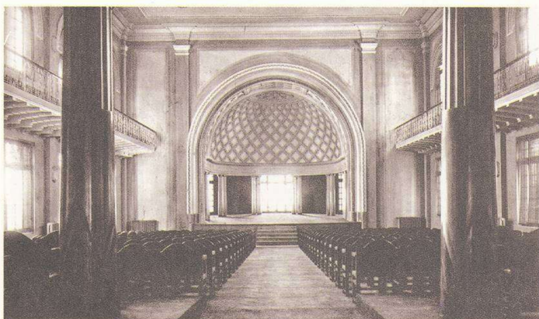
ZARAGOZA - GRUPO ESCOLAR COSTA. Salón Teatro
