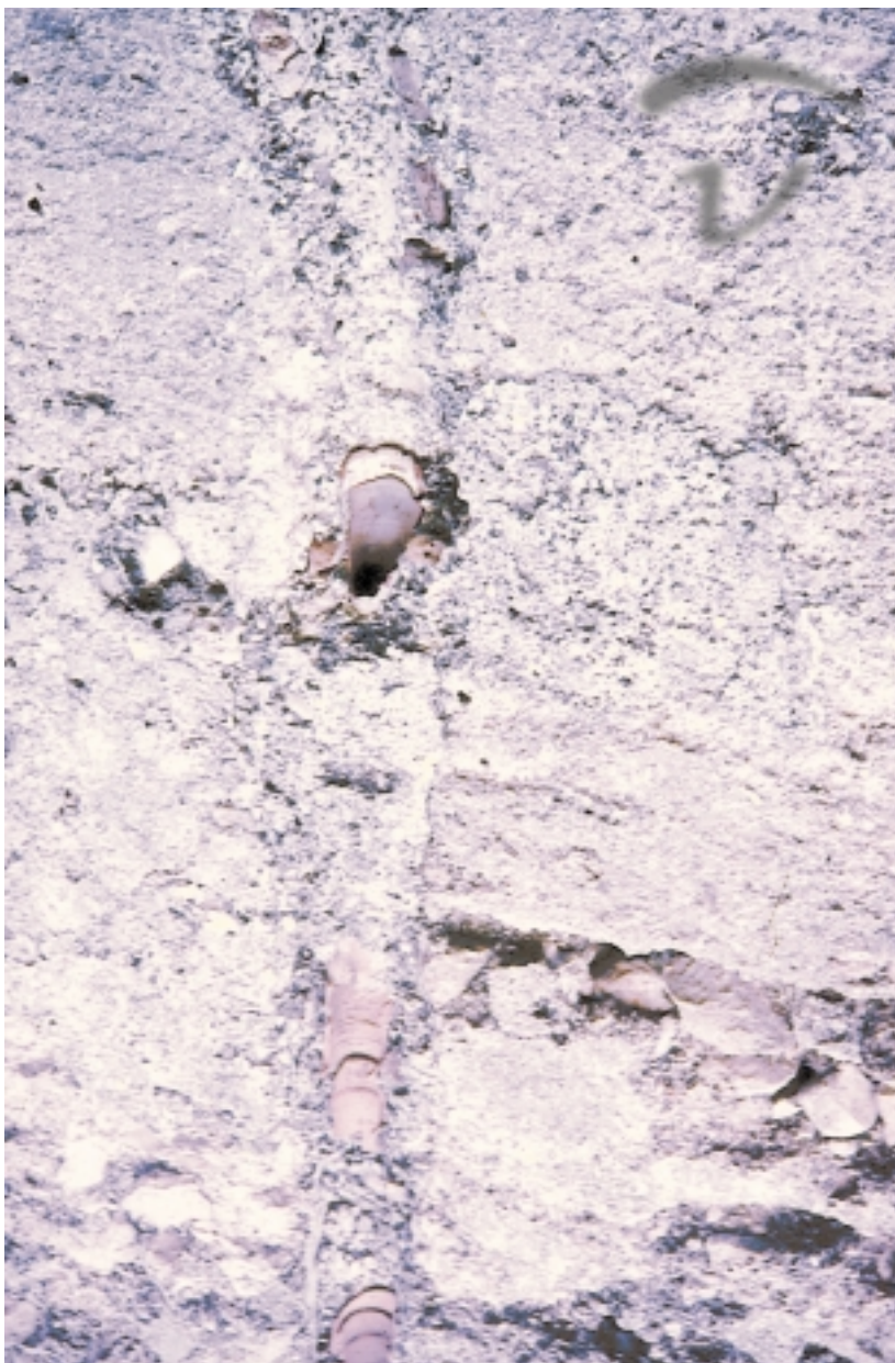
Foto 273. Perputxent. La conducció del aigua de la cuberta o part superior a la inferior -aljibe o desagüe- se realitzava per mitjà de conductes de alfareria.
