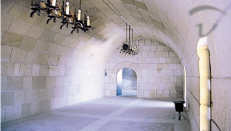
Foto 223. Alicante. Su castillo, aunque muy destruido, aún conserva restos de torres, aljibes o salas que, tras la restauración, muestran este aspecto extraño.
