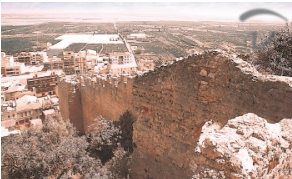
Foto 200. Detalle posterior de la torre albarrana.
