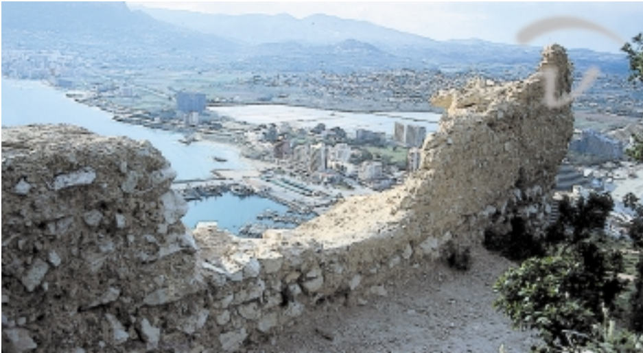
Foto 193. Vista general y ruinas de estructuras.
