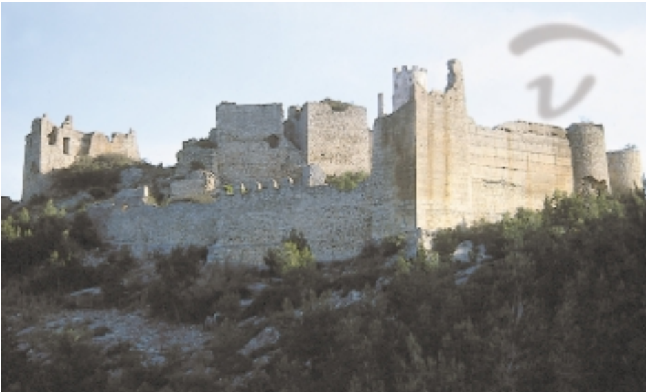
Foto 219. Restos de estructuras exteriores.
