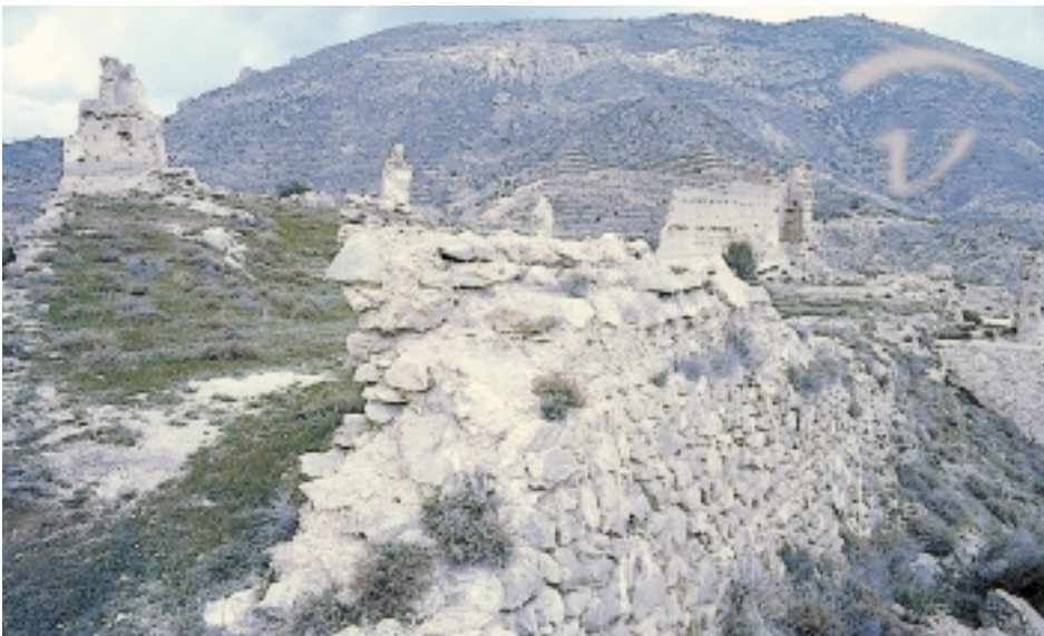
Foto 166. Restos de su estructura superior.
