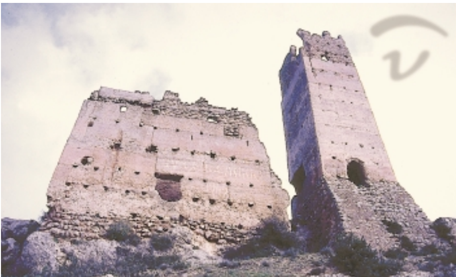
Foto 163. De nuevo la torre se sitúa sobre un talud de mampostería.
