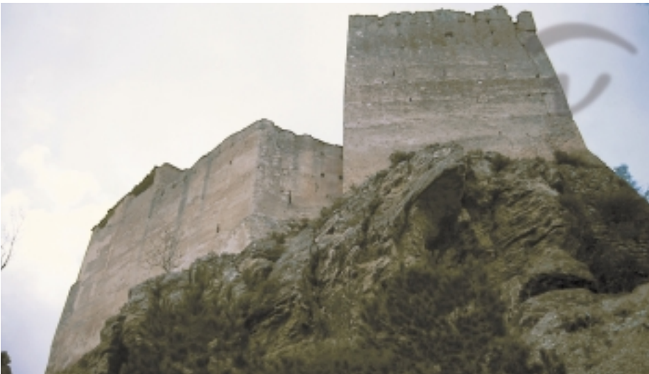
Foto 114. Su torre se asienta sobre un apoyo de mampostería para nivelar el suelo.
