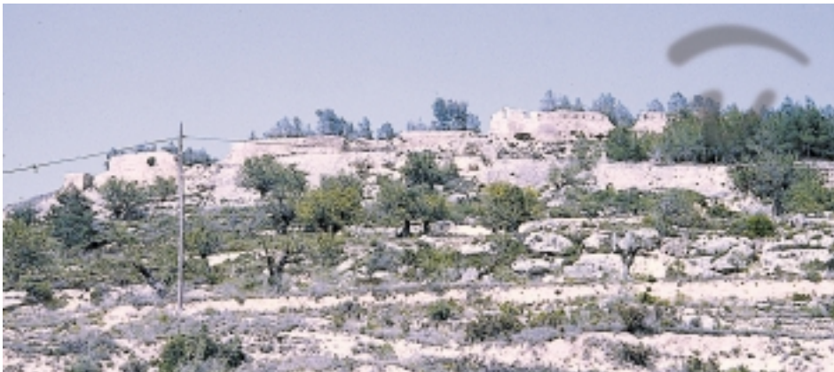
Foto 92. Es el primer castillo que aparece en esta vía que se dirige hacia el interior. Todos sus elementos están muy deteriorados.
