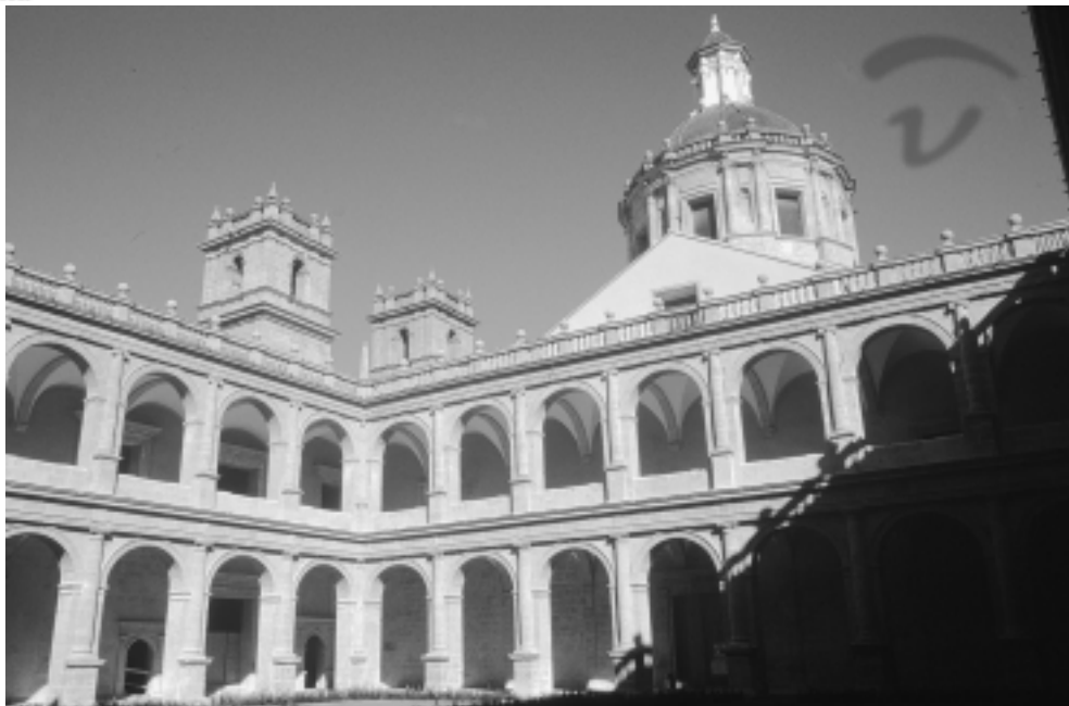
Vista del claustro sur
