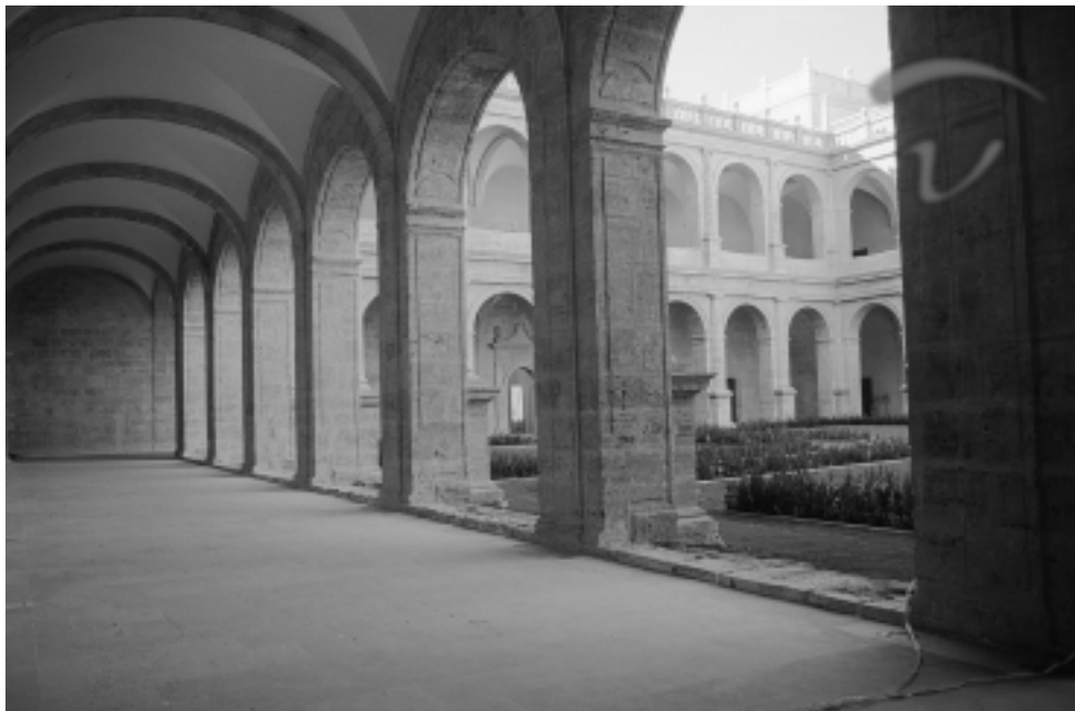
Vista del claustro sur
