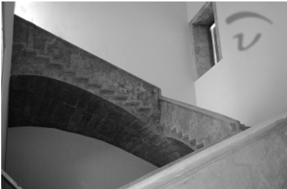
Tramo de la escalera principal, en el lado oeste
