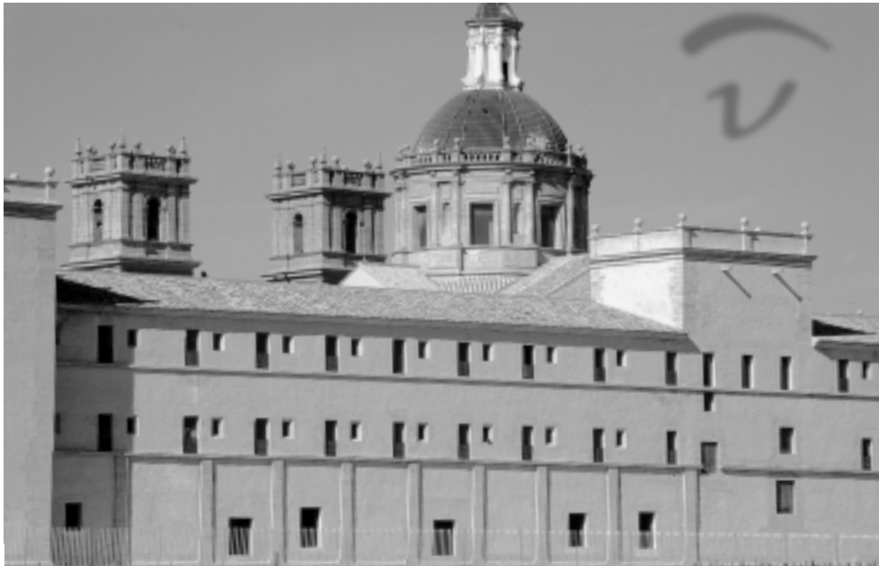
Exterior del lado este del claustro sur, entre la torre de la escalera y la del prior.
