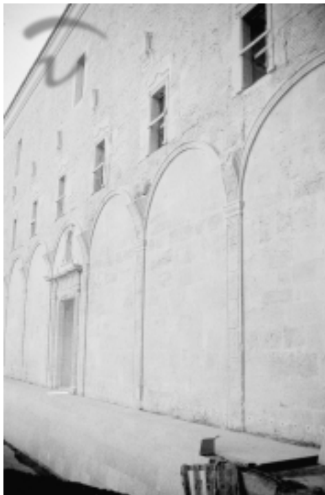
Lado este del claustro norte.
