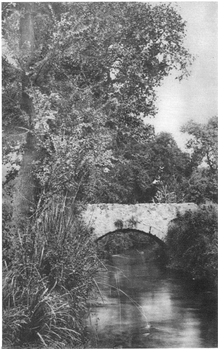
Acequia Condal, Barcelona. — Puente romano
