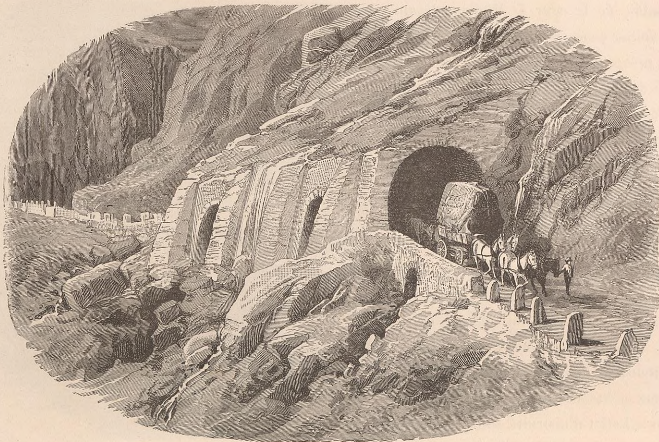
UNE GALERIE, ROUTE DU GOTHARD.
