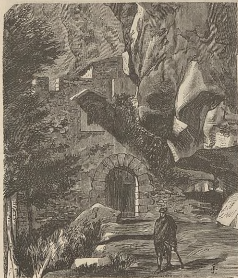
Entrada de la casa de San Miguel del Fay.
