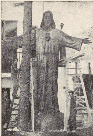
11. - Construcción de la estatua en el Palacio Episcopal.
