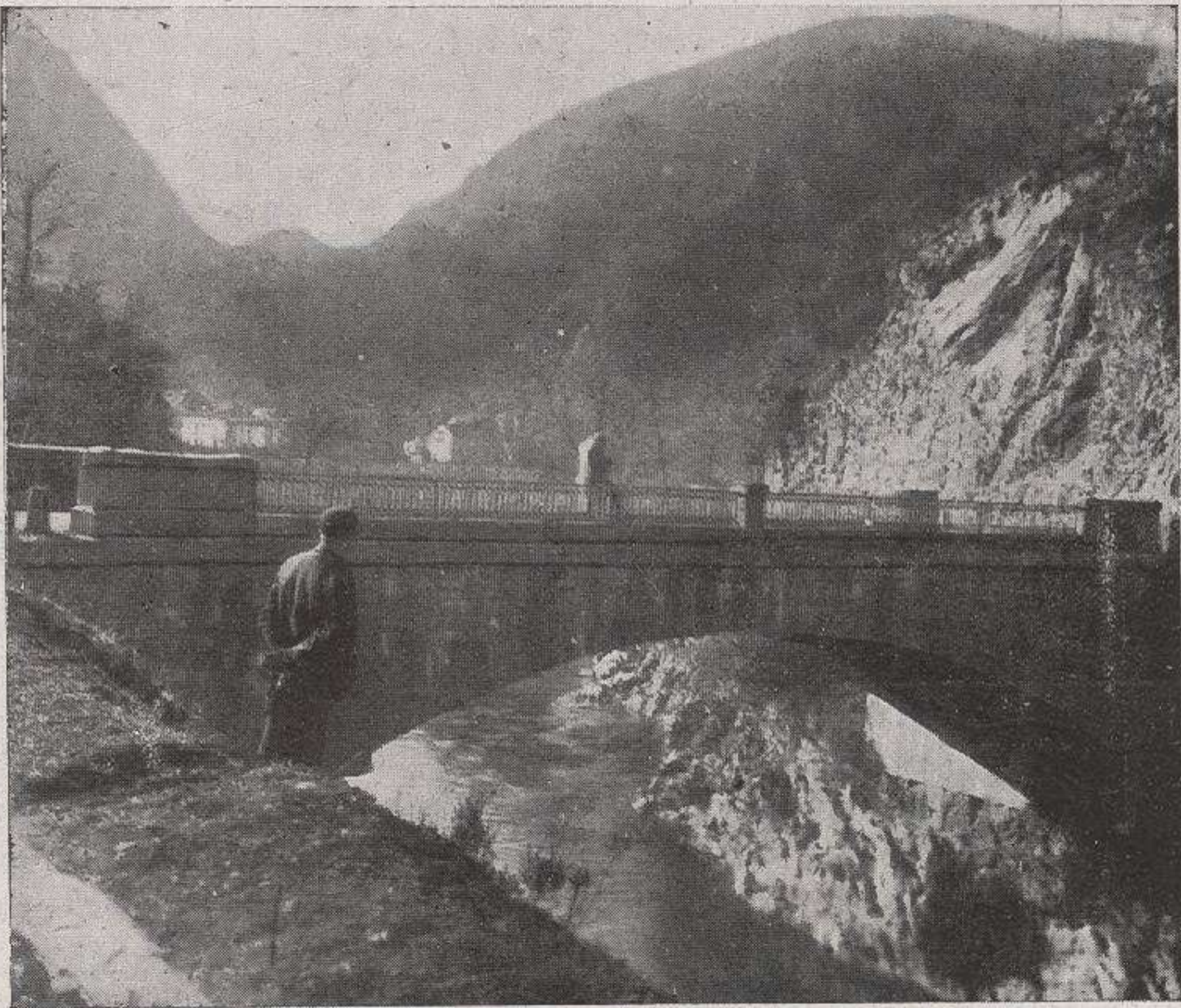
Carretera de Ponga.
