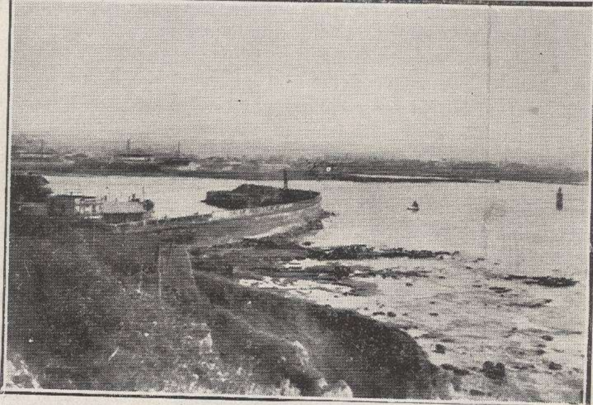
GIJON. —Entrada al muelle interior.
