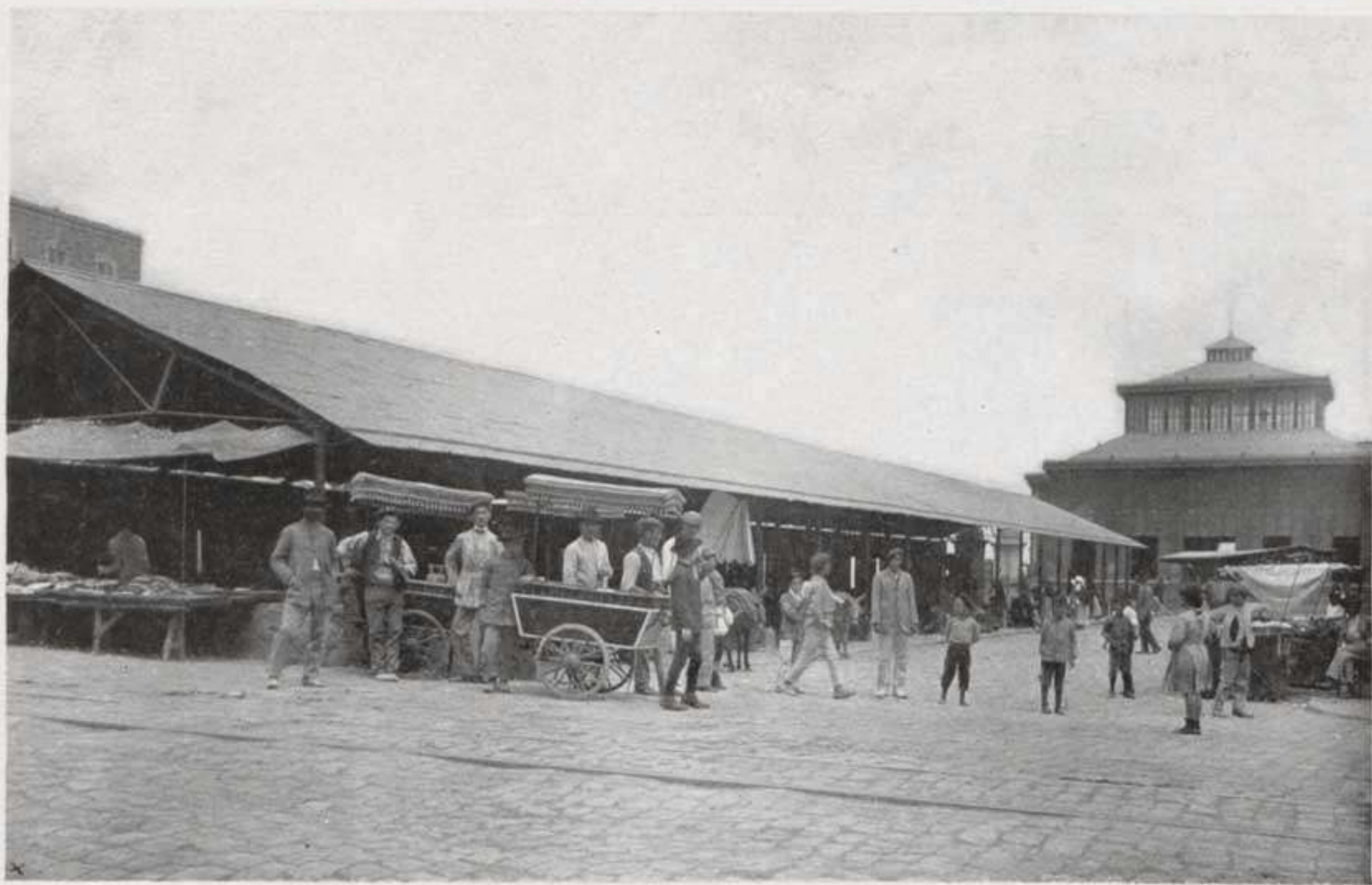
Este nuevo edificio fué levantado á la derecha del Guiniguada, cerca del puente de López Botas.
