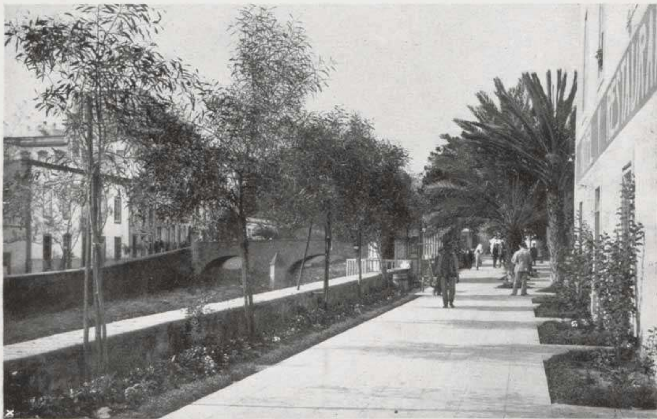
Divide la Ciudad, pasando entre los barrios de Vegueta y de Triana, que se comunican mediante los puentes del Verdugo y de López Botas.
