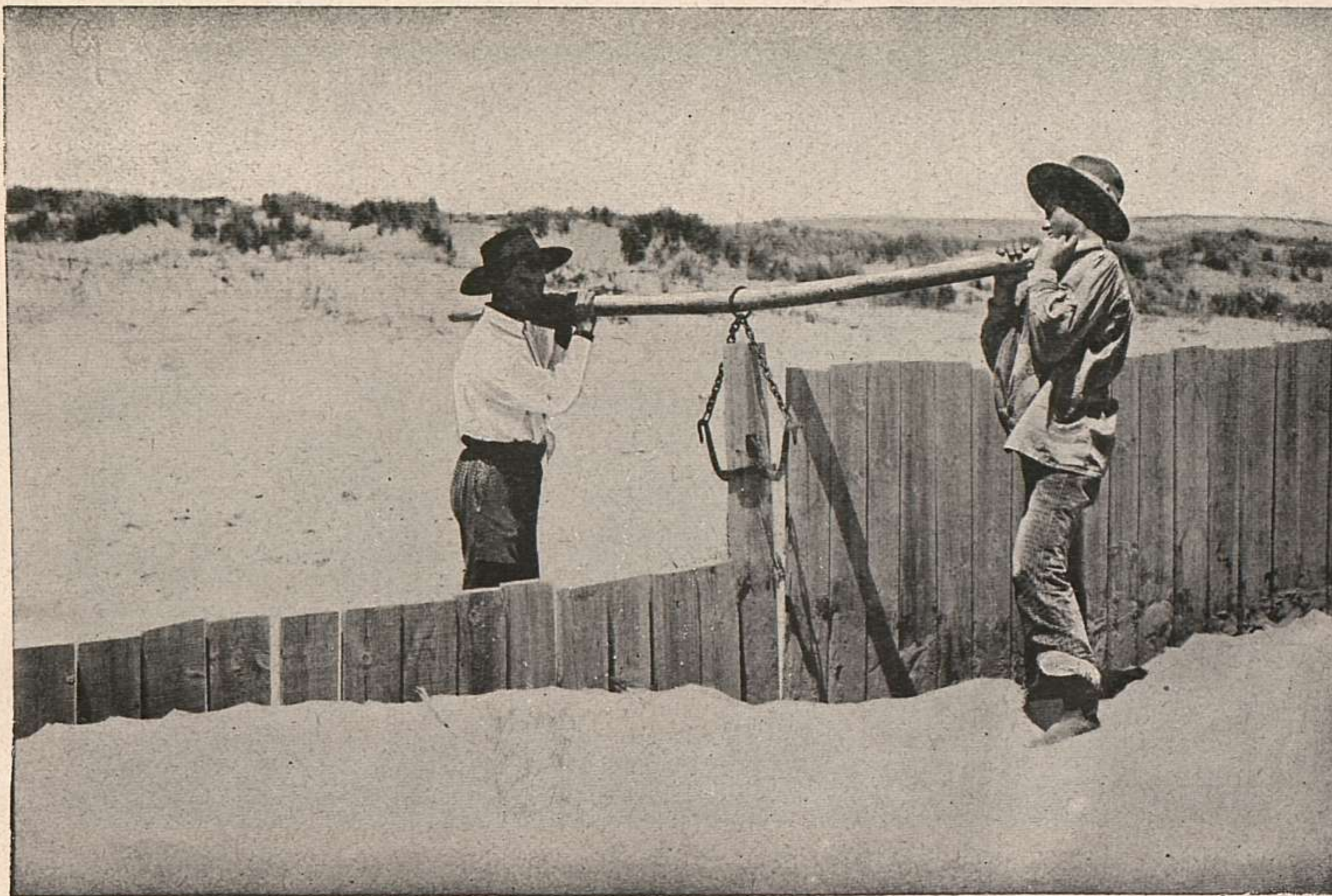
DUNAS DE GUARDAMAR—LEVANTANDO LAS TABLESTACAS DE LA CONTRADUNA
