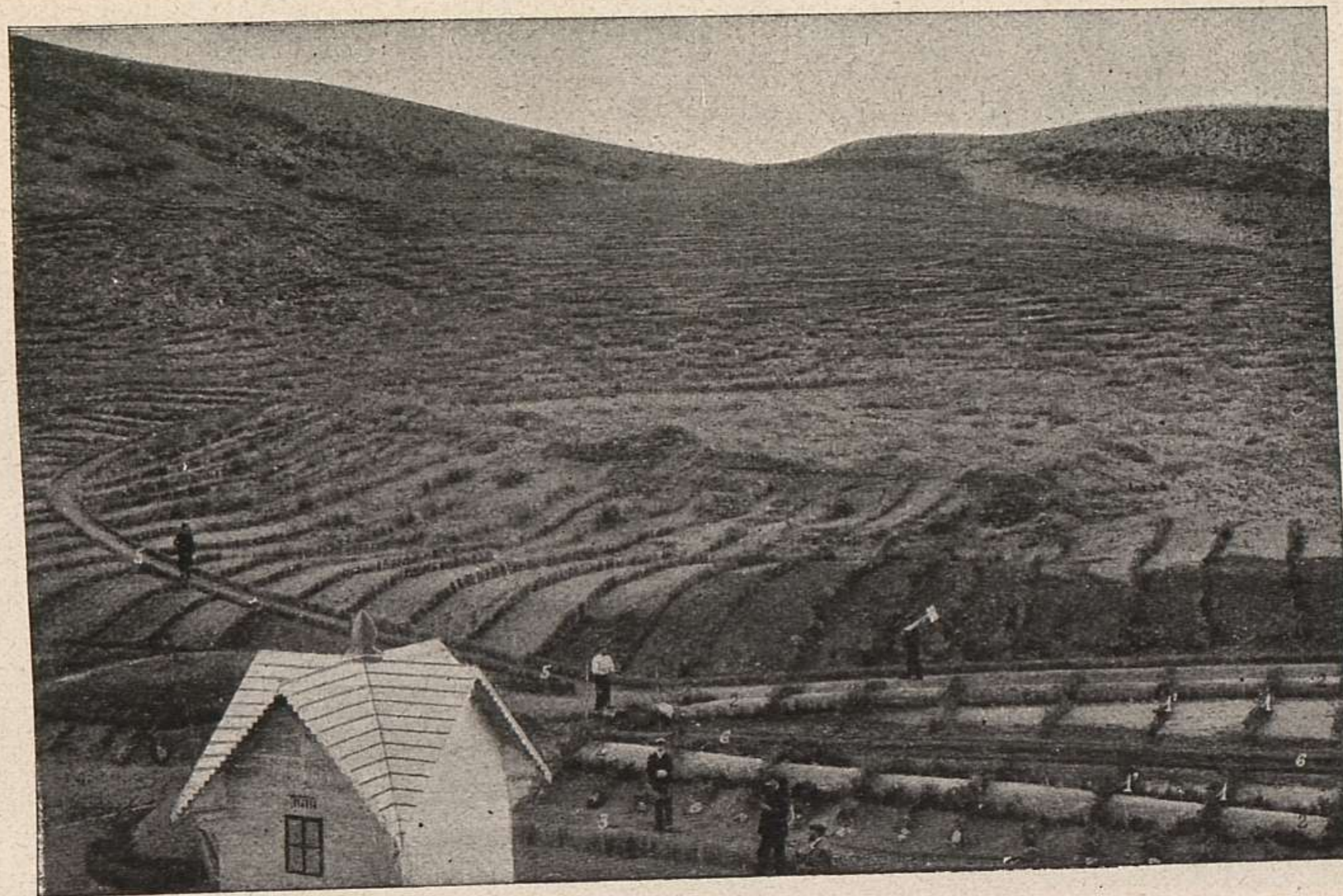
DUNAS DEL GOLFO DE ROSAS - FIJACIÓN DE ARENAS POR LÍNEAS DE BARRÓN
