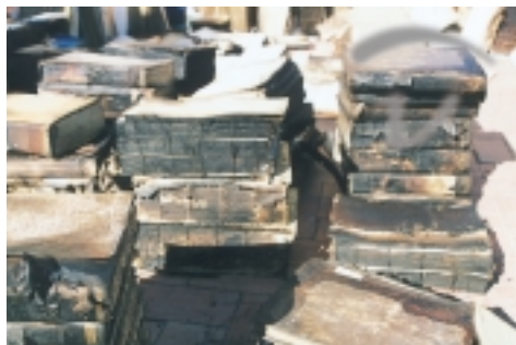
Figura 125.- Material dañado por un incendio, recuperable. En primer lugar hay que extraer cuidadosamente el material carbonizado.
