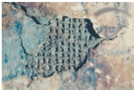
Figura 40.b- Estado de degradación de la tela de cáñamo.
