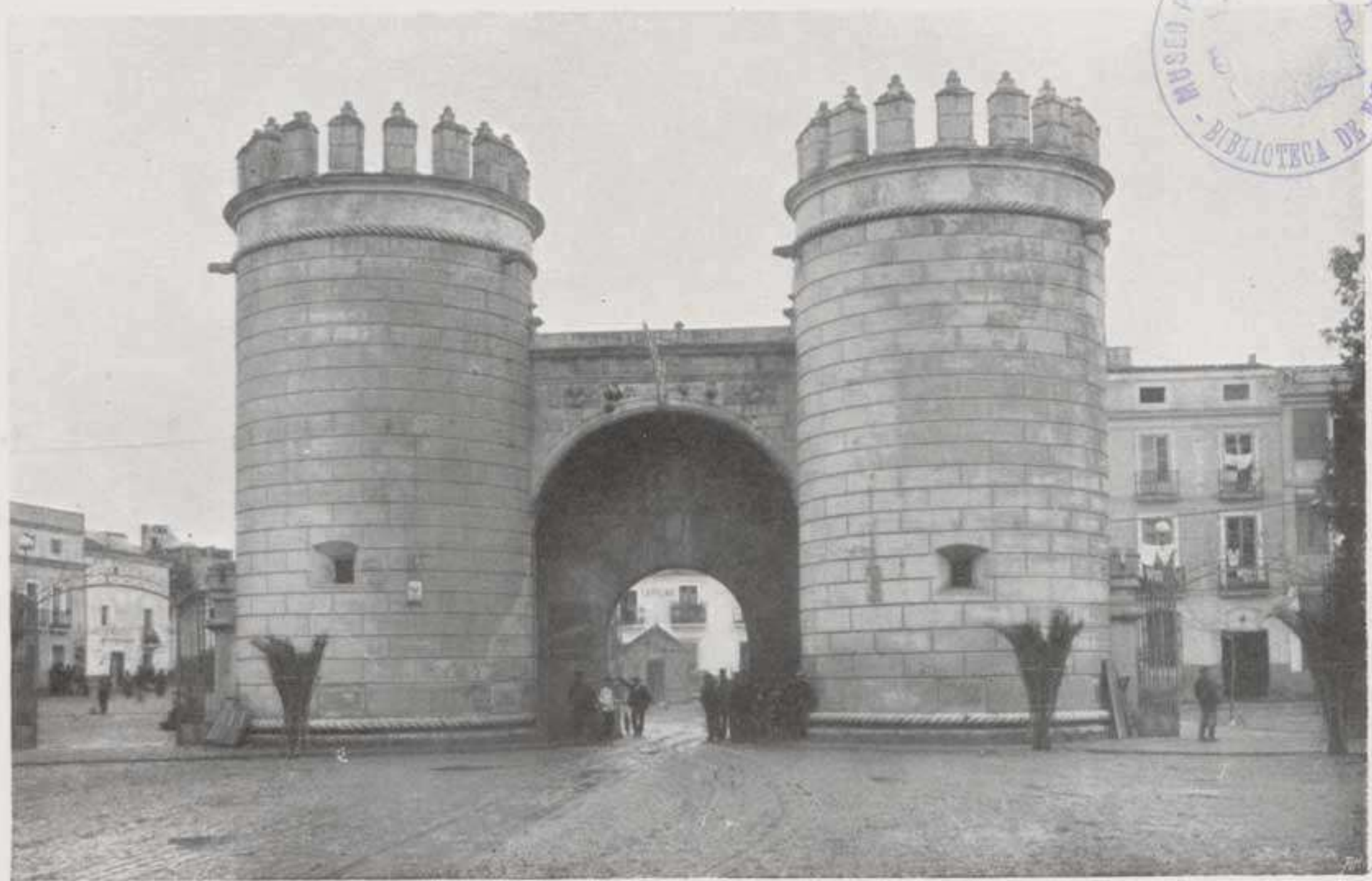
Defendida por dos robustos cubos almenados, es la más importante de las tres que daban entrada á la Ciudad, abriéndose delante del puente á orillas del Guadiana.
