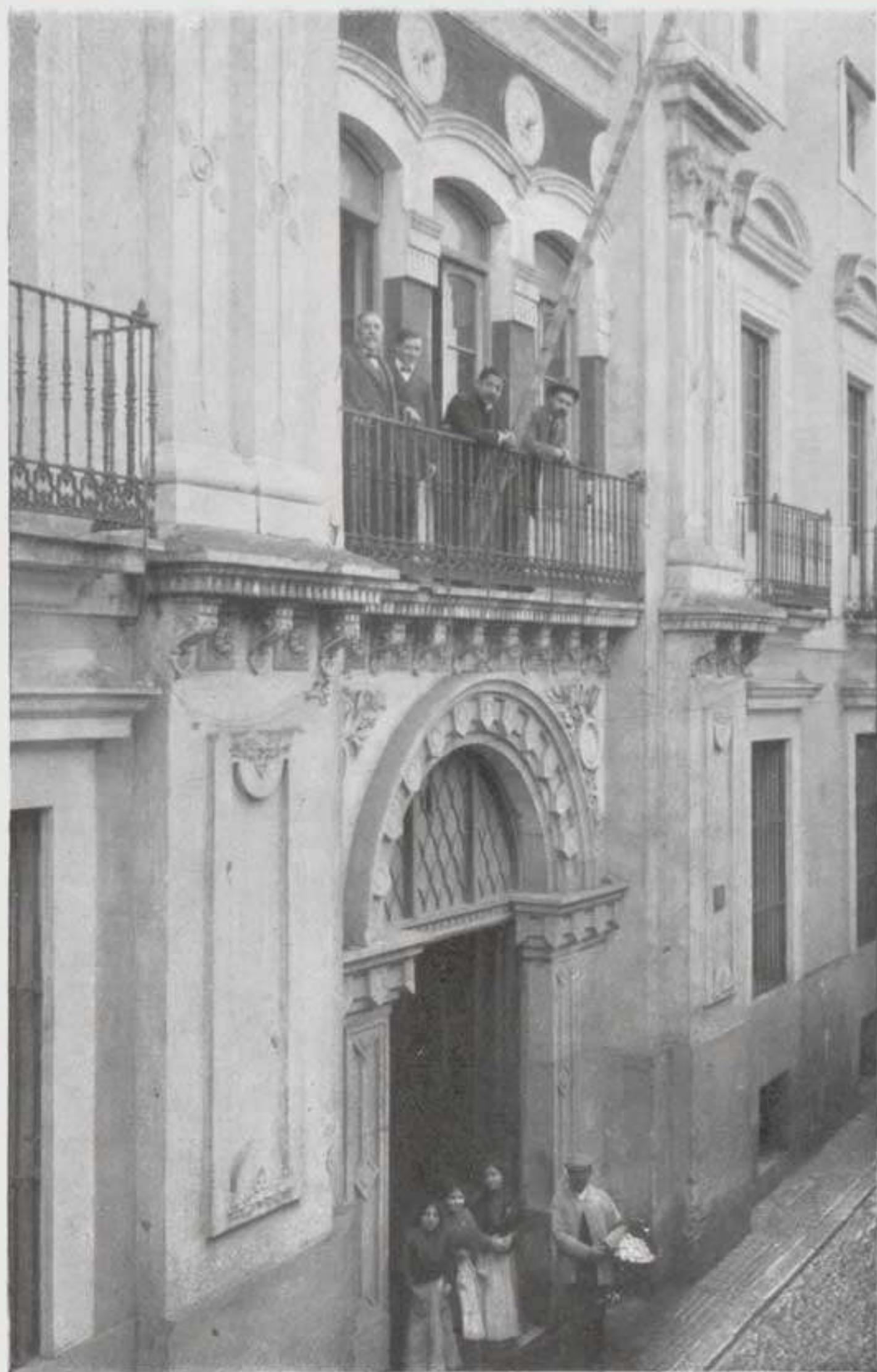
Sencillo en su construcción, este edificio se halla dotado de espaciosa dependencias, suficientes para los fines á que está destinado.
