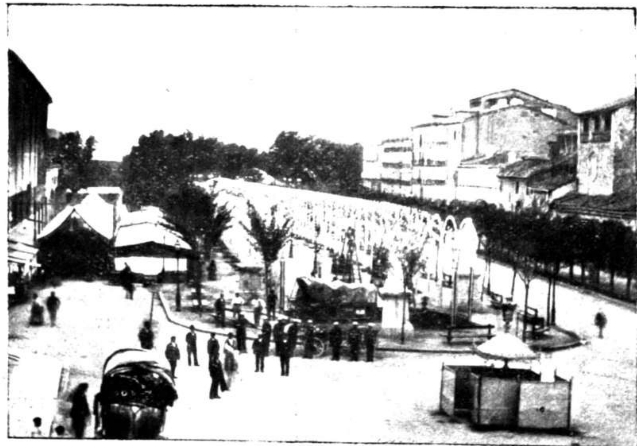
Iluminación en el Paseo de Valencia, verificada a fines del siglo pasado.
