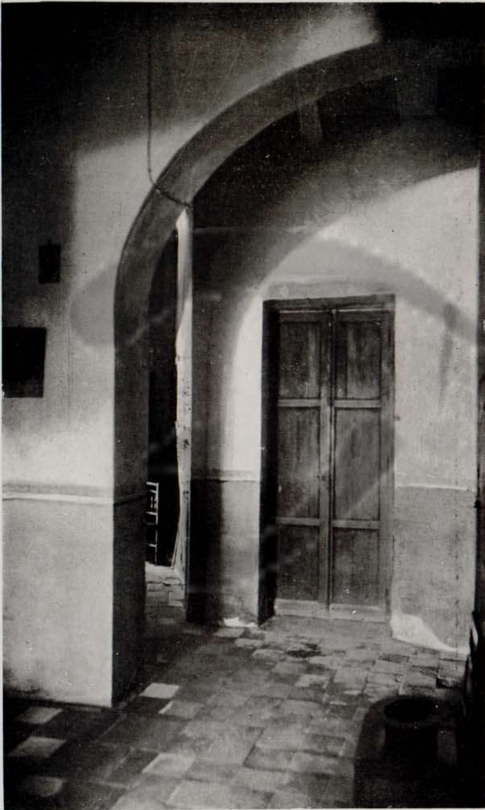
ARCO DE LA PUERTA BEB-ALAHIX EN EL INTERIOR DE LA CASA NÚMERO 5 DE LA CALLE DE SALINAS, VALENCIA
