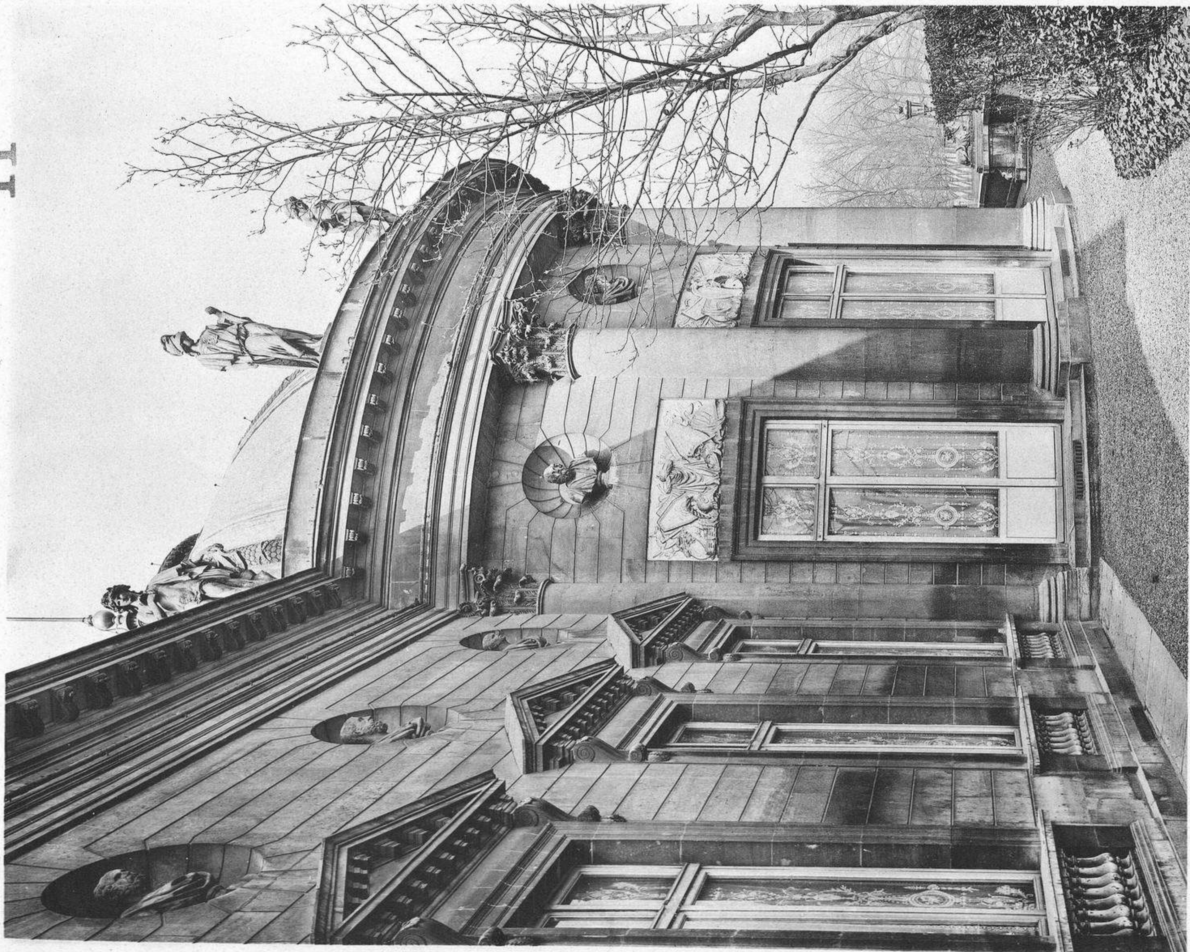
PARIS, ANCIEN HOTEL DE SALM, rue de Lille, 64; construit par Pierre Rousseau, en 1786 (palais de la Légion d'honneur depuis 1802). Détails de la façade postérieure, sur le quai d'Orsay.
