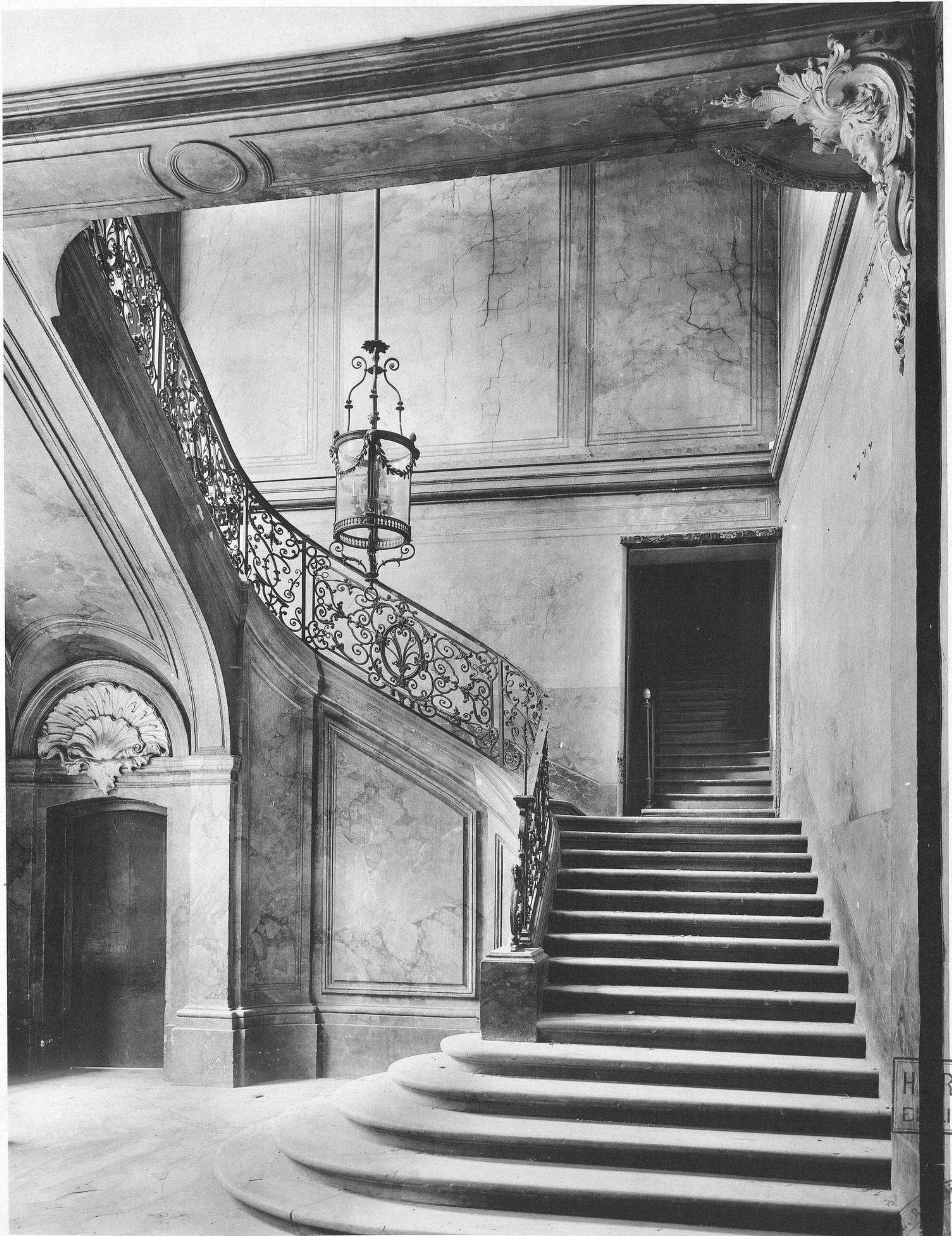
PARIS, ANCIEN HOTEL DE M me DU GUÉ, rue du Regard, 3; vers 1720 (démoli en 1907). Vestibule et grand escalier.
