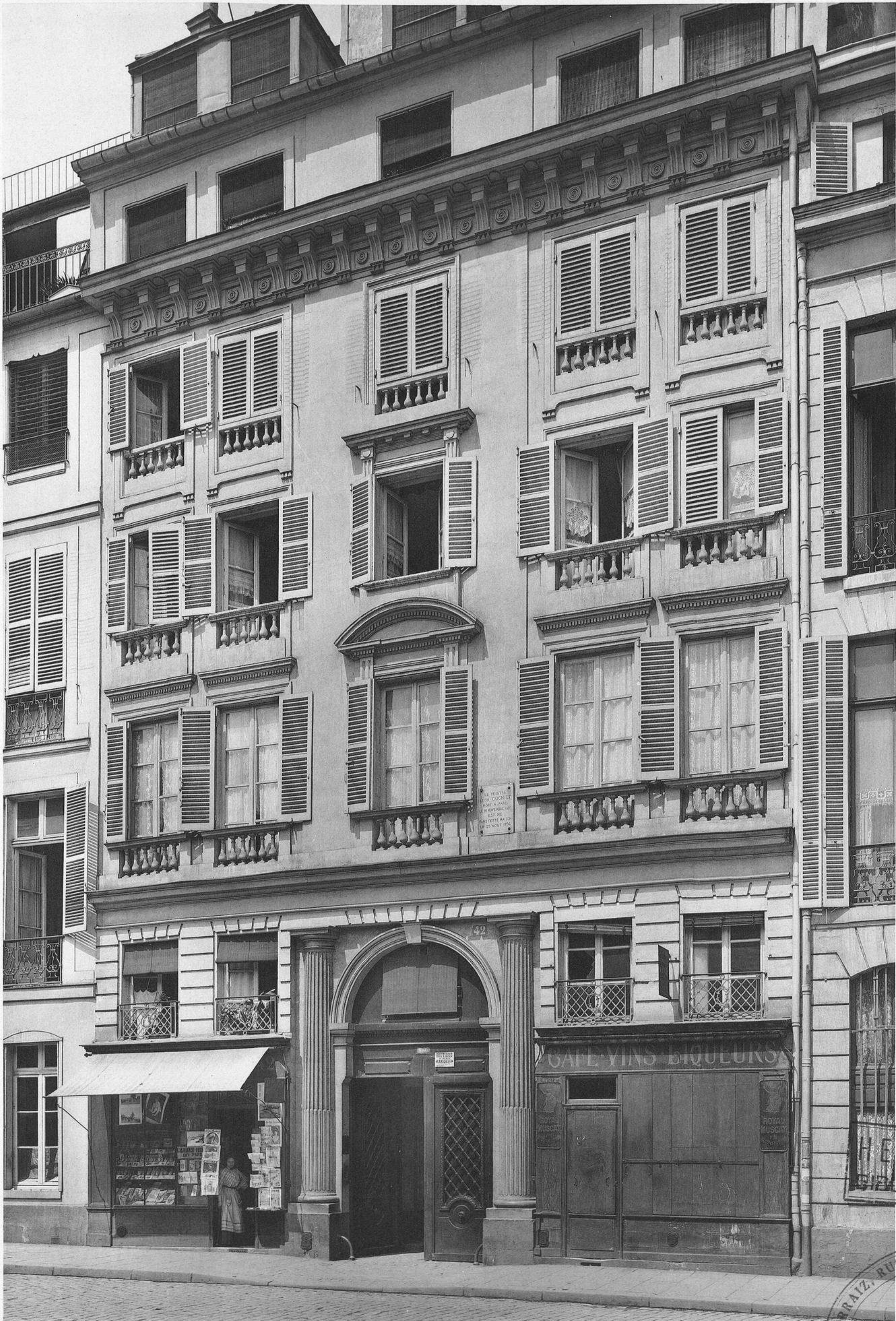
PARIS, IMMEUBLE rue du Cherche-Midi, 42; vers 1760. Façade principale.
