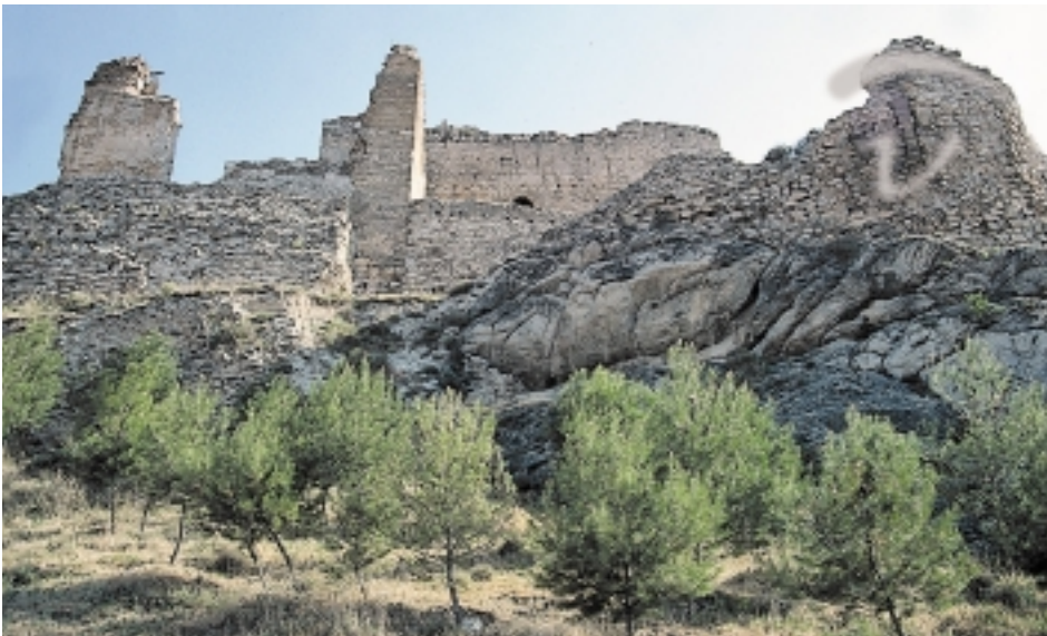
Foto 108. Vestigios de sus antiguas estructuras.
