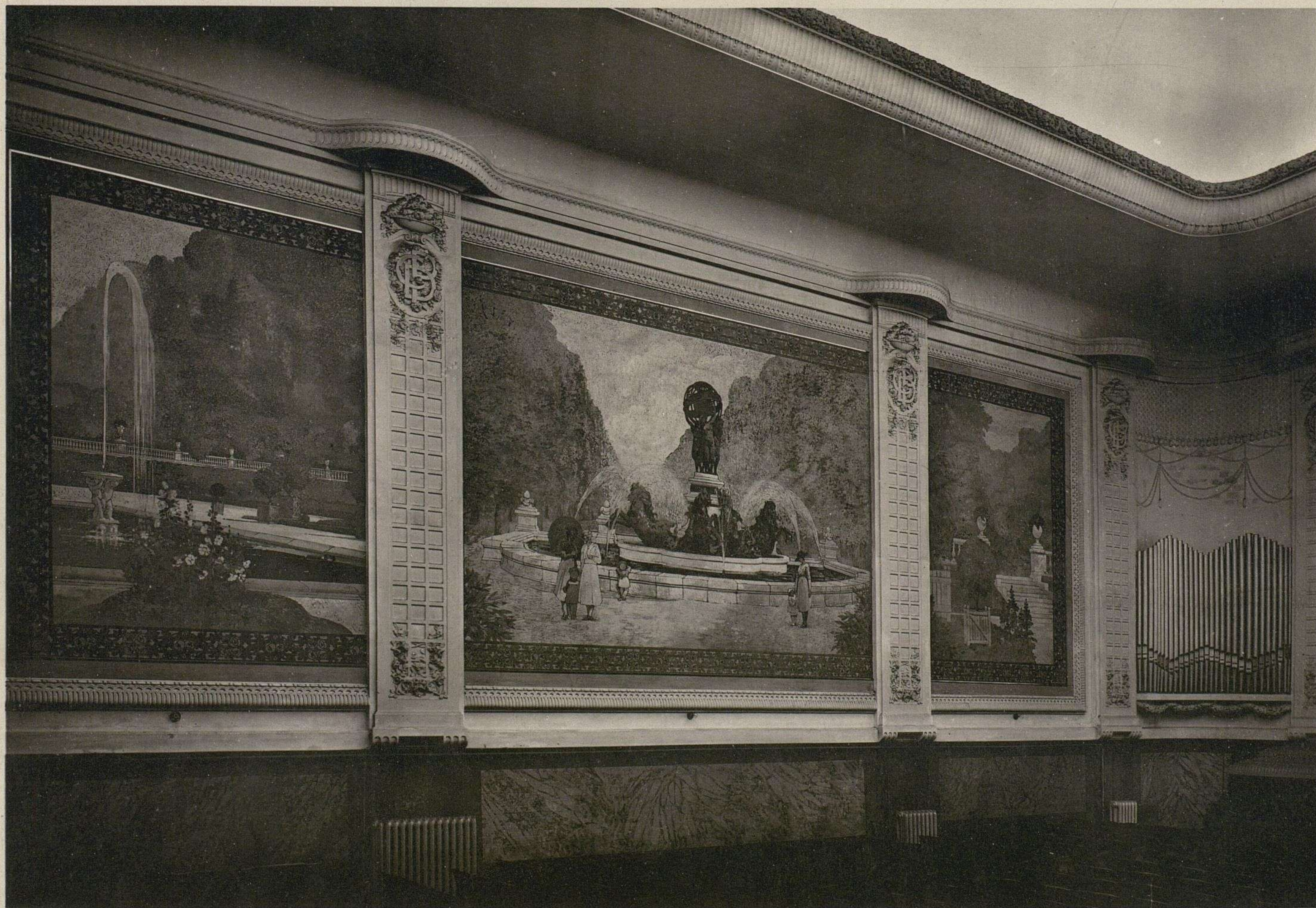
DANTON-CINÉMA-PALACE, à Paris. — M. E. VERGNES, architecte. — Vues intérieures.
