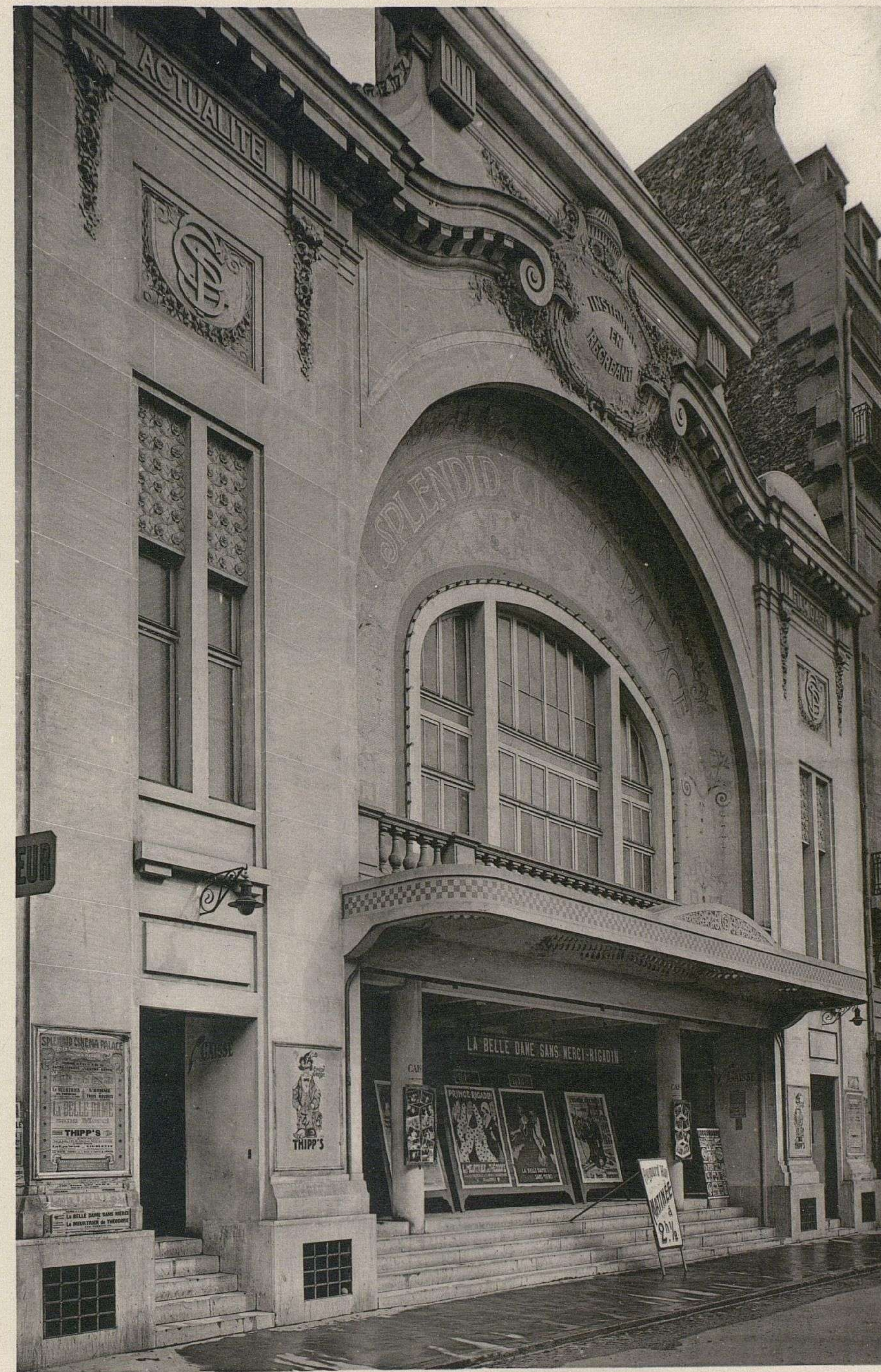
SPLENDID-CINÉMA, à Paris. — M. E. VERGNES, architecte. — Façade et Détails de la Façade.
