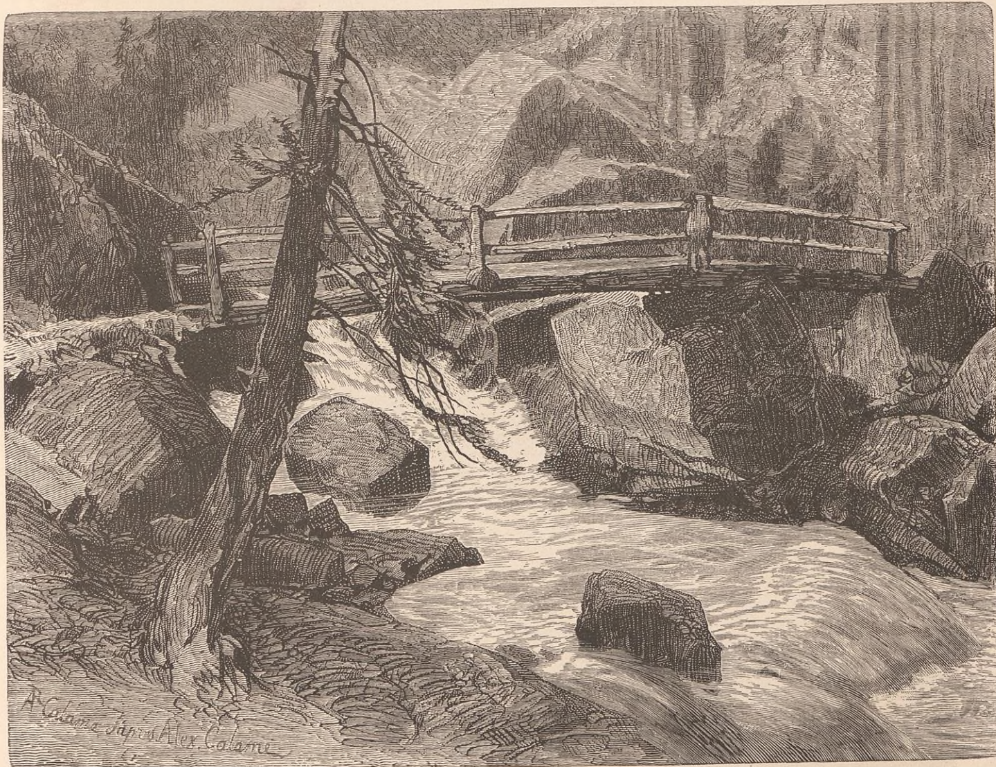
UNE PASSERELLE DU GIESSBACH.
