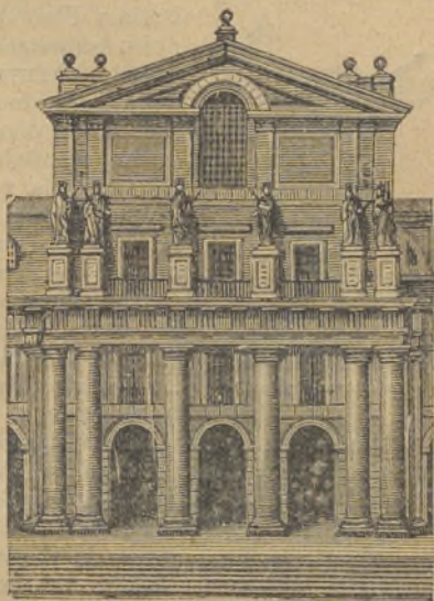
Fachada del templo del Escorial. (Estilo grecorromano.)
