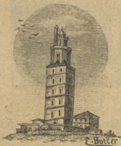
Torre de Hércules, en Coruña.
