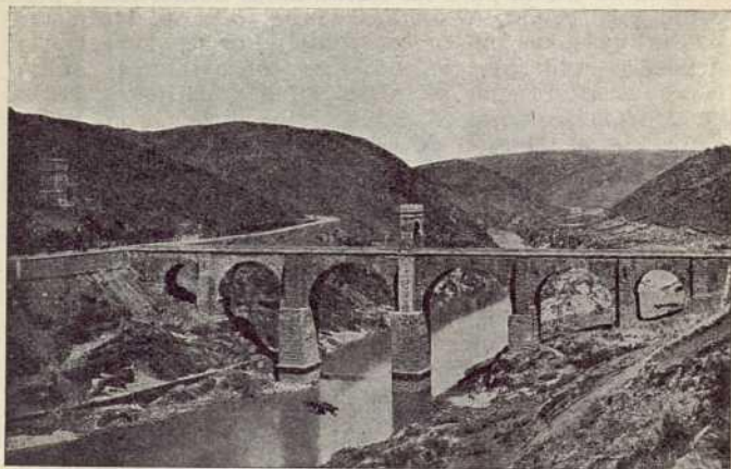
Fig. 160. Puente romano de Alcántara (Cáceres)
