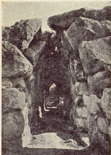
FIG. 69. Galería abovedada de Tirinto
