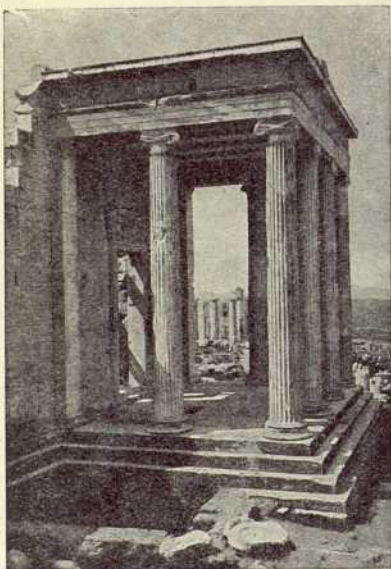
FIG. 93. Pórtico Norte del Erecteion, en la Acrópolis de Atenas
