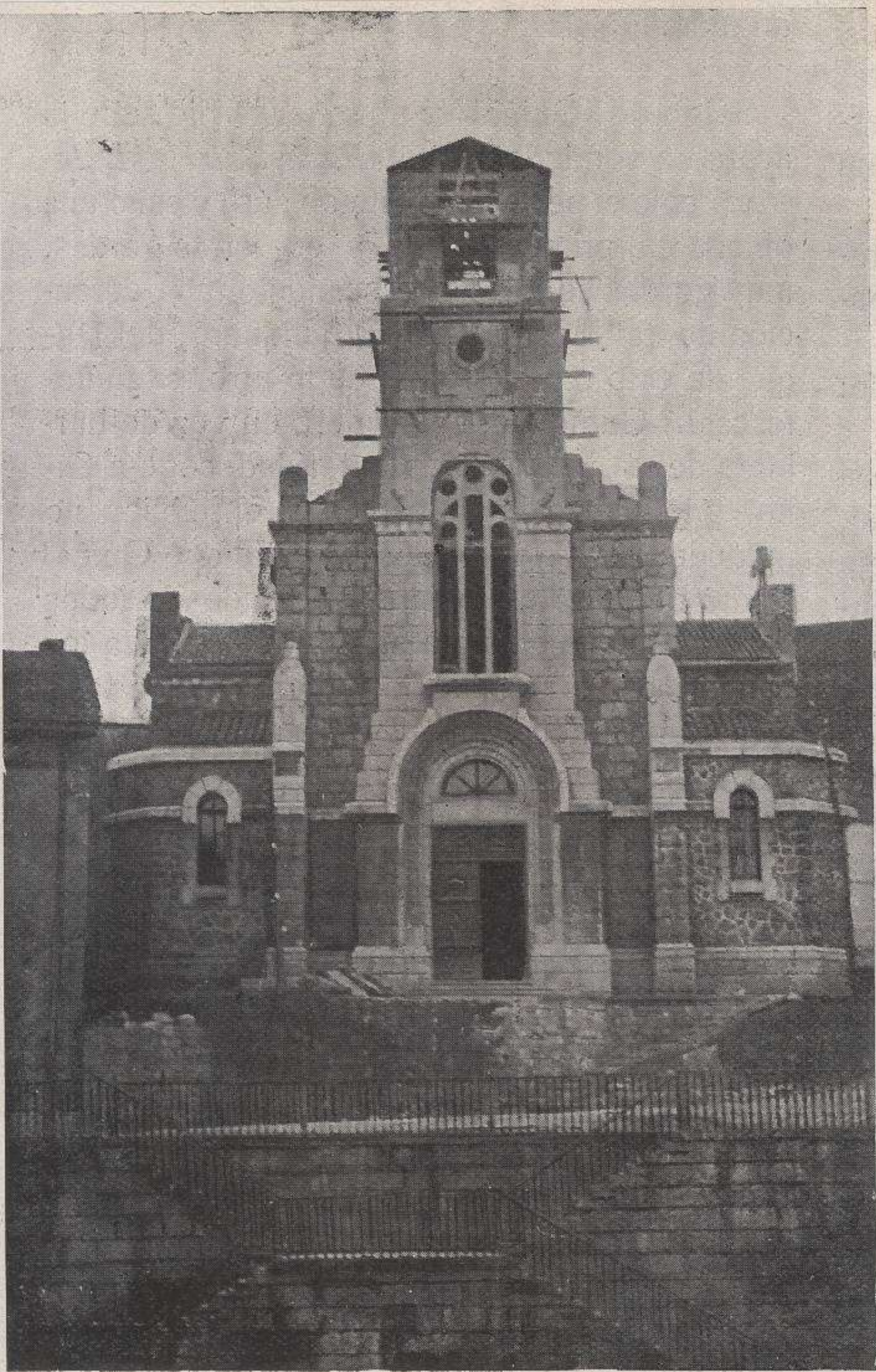
Fachada principal de la iglesia de Infiesto cuya torre está próxima a terminarse.
