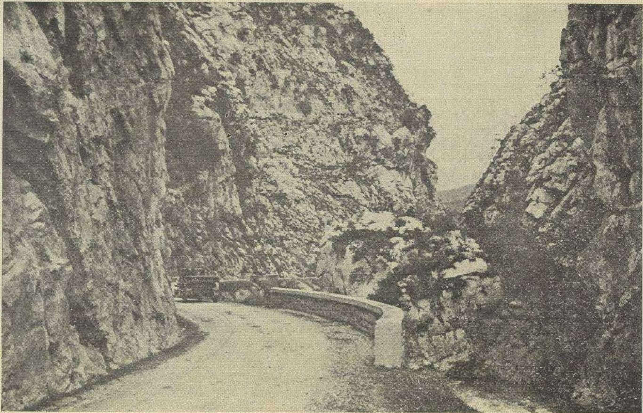
Carretera de Teverga
