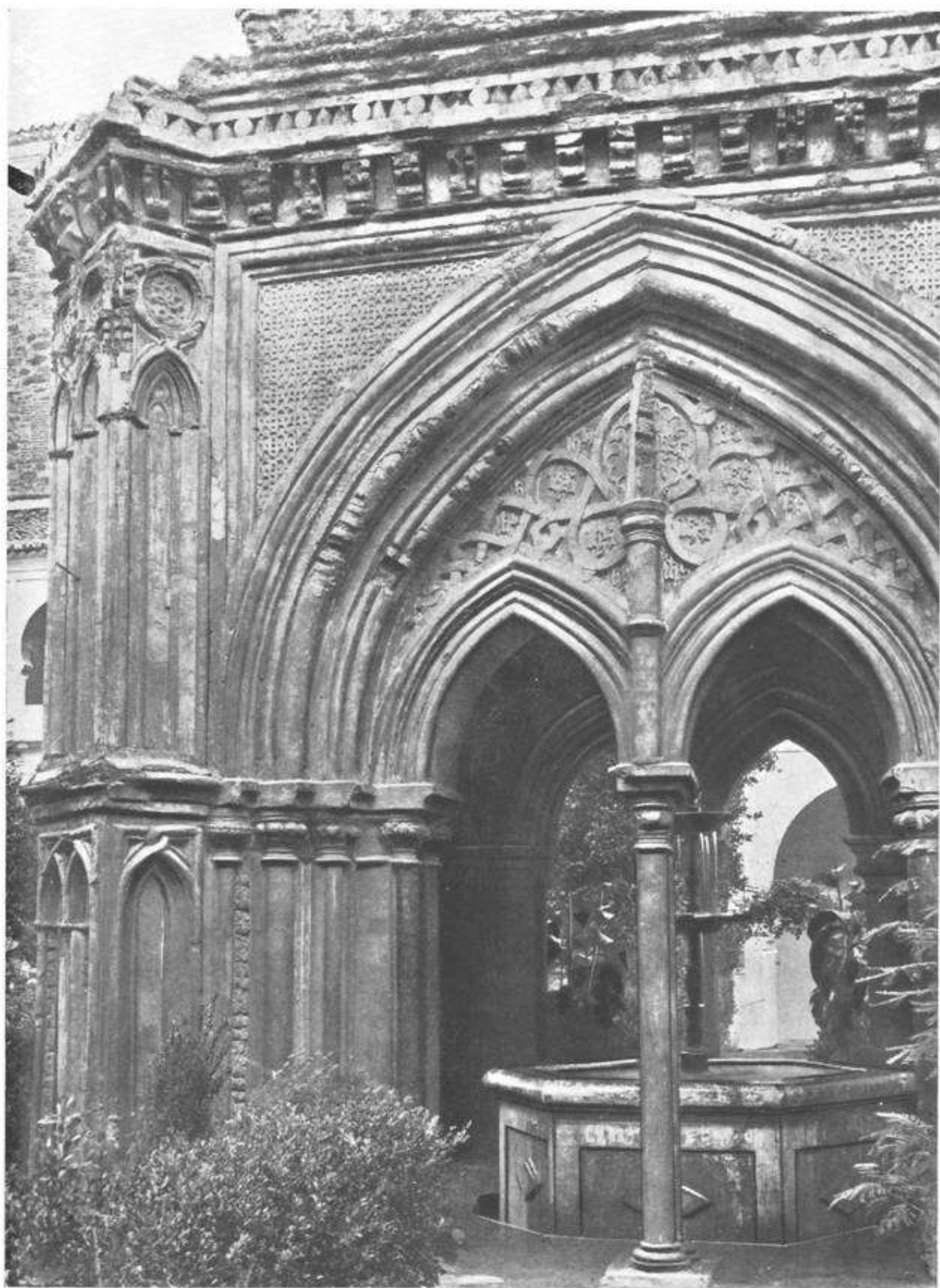
DETALLE DE LA GLORIETA CENTRAL
