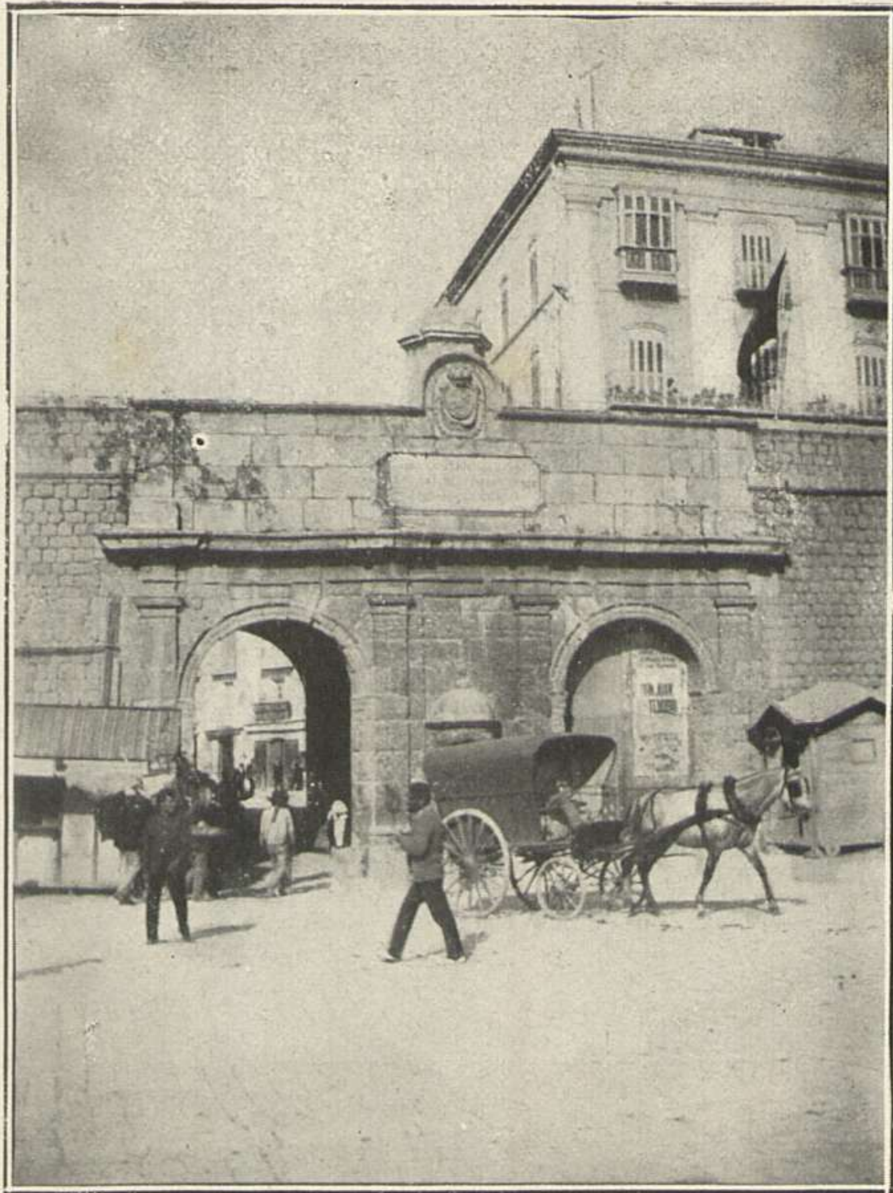
1892 - Una vista de las Puertas del Muelle, antes de comenzar la demolición de las murallas que circundaban la ciudad.
