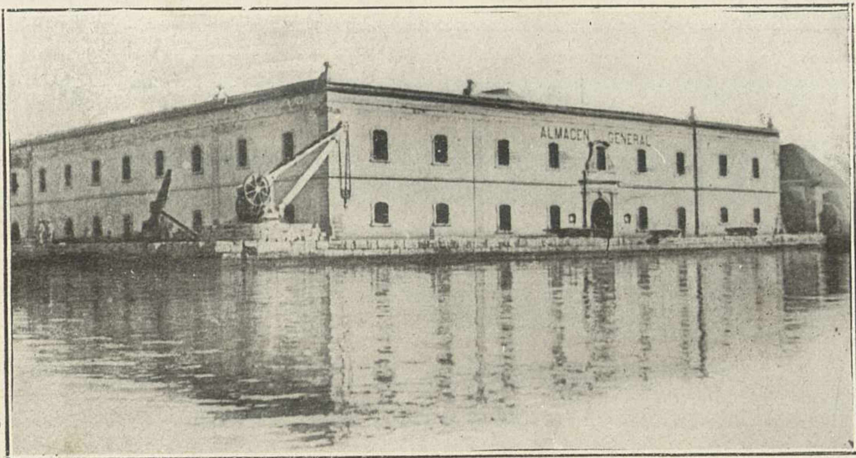
Almacén general del Arsenal de Cartagena, construido a mediados del siglo XVIII.
