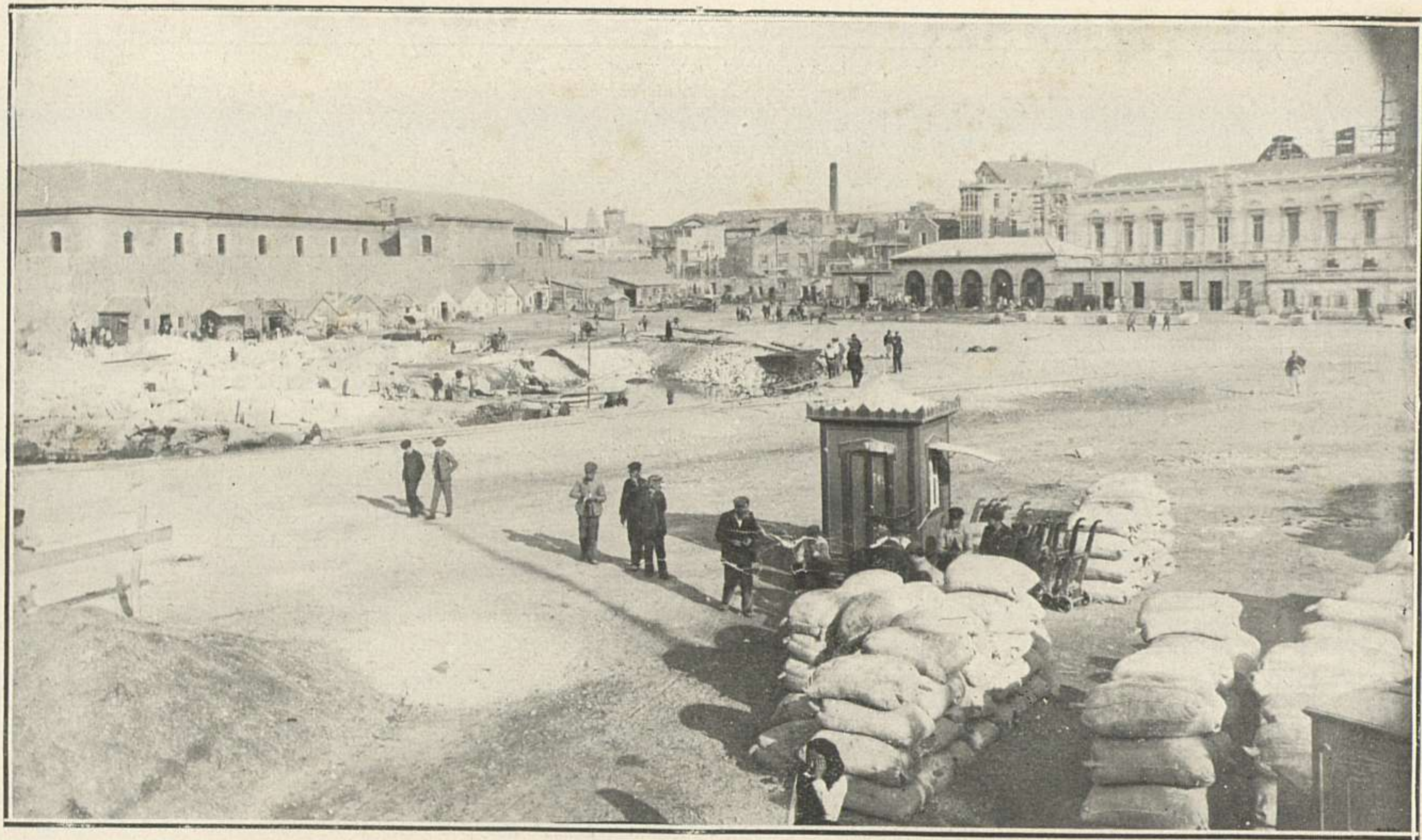
1906 - Relleno de la antigua dársena de botes del Muelle de Cartagena, sobre la que se levantó el monumento a los héroes de Cavite y Santiago, y el edificio de la Junta de Obras del Puerto.
