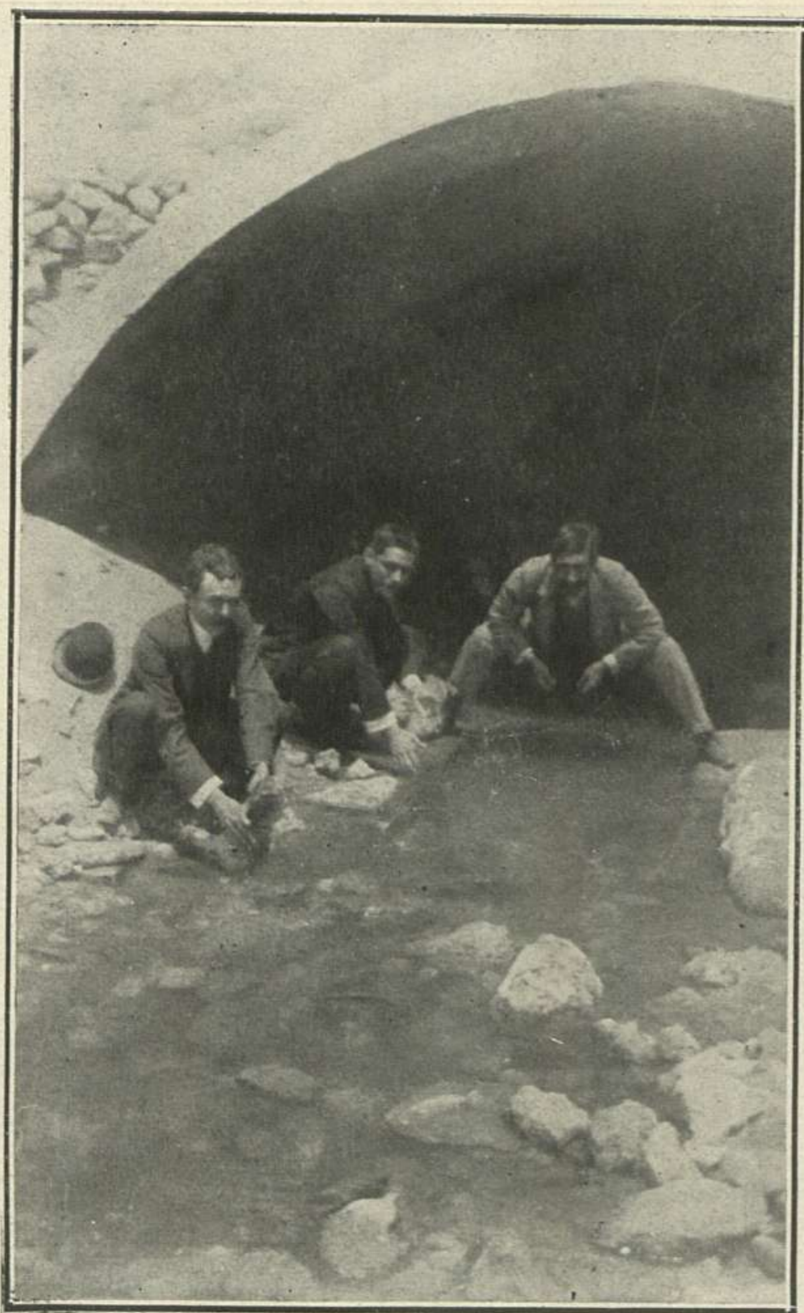
Túnel, aún existente, por el que se des- viaron por debajo de la Plaza de España, hacia la rambla de Benipila, las aguas del cauce de la Anguililla.
