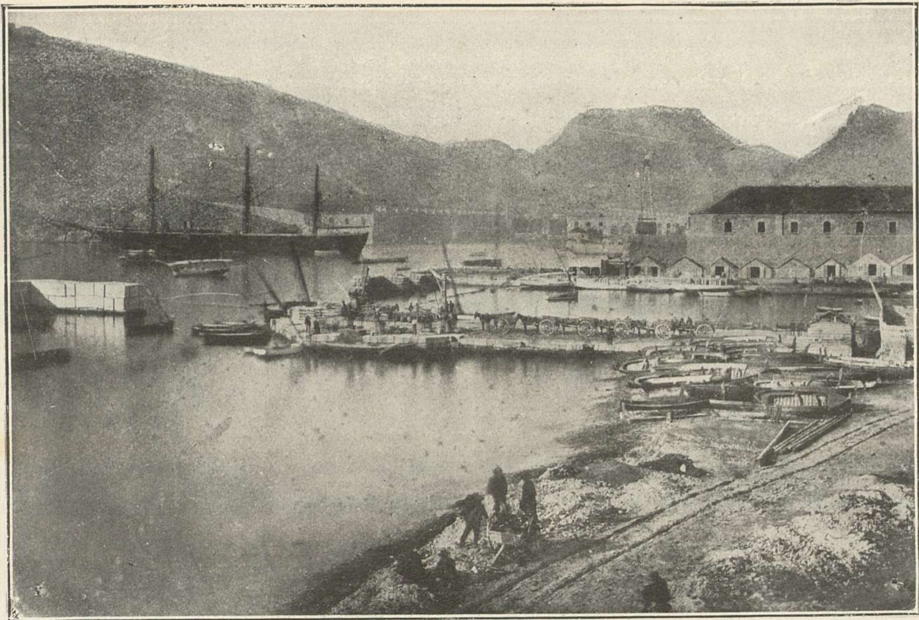
La dársena de botes, donde se levantó el monumento a los Héroes de Cavite y Santiago; el espigón del antiguo muelle comercial, al iniciarse las obras del de Alfonso XII, que se inauguraron en 1875.
