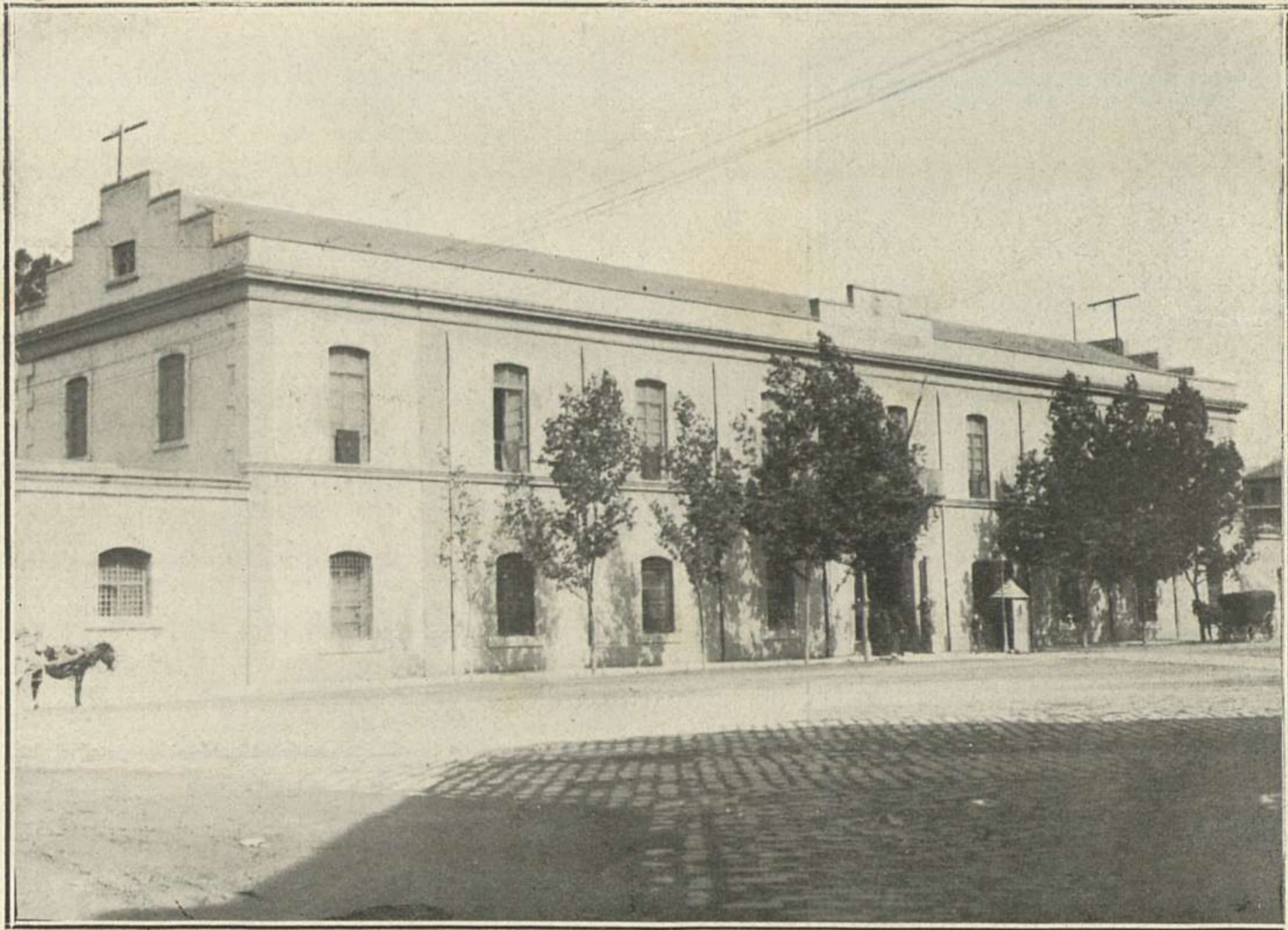
Fachada principal del Parque de Artillería, como se halla actualmente.
