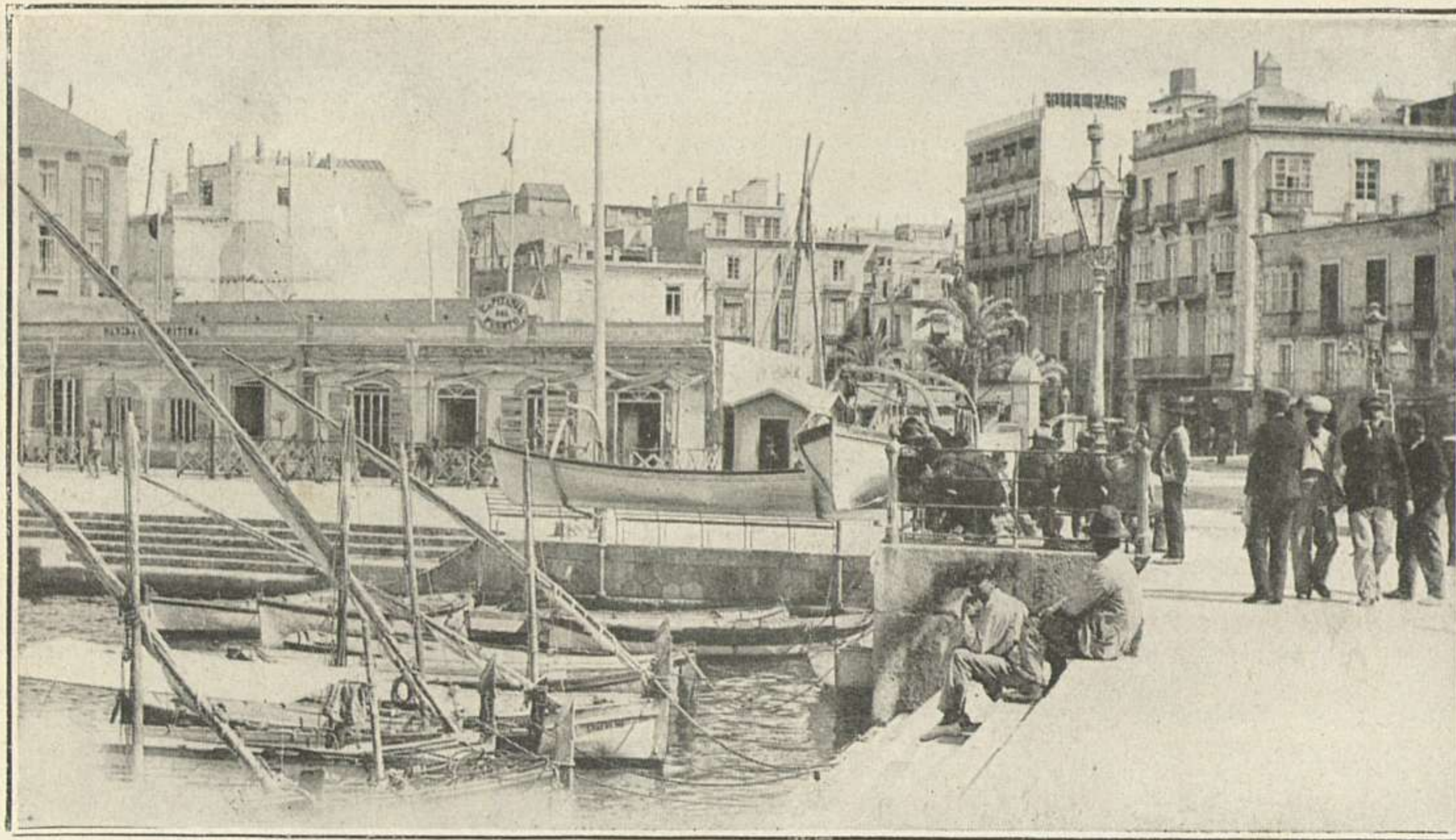
1904 - Antigua dársena de botes, después de derribadas las puertas del Muelle y antes de ser construido el nuevo Palacio Municipal.
