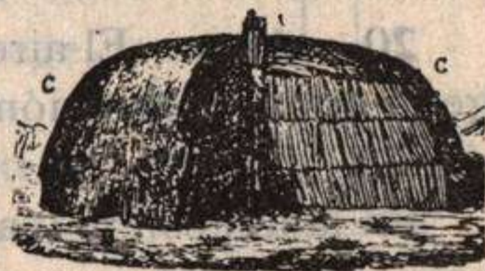
Fig. 11.-Obtención de carbón vegetal.
